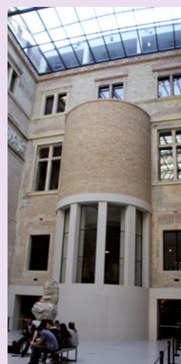
Die alte Architektur wurde beim Wiederaufbau beibehalten – allerdings mit neuen Elementen aus Sichtbeton.
