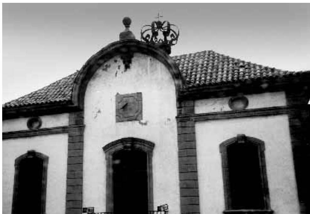
14. Testera de la contrafaçana de la Universitat de Cervera.
