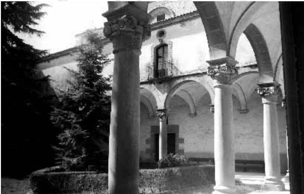
81. Interior del claustre del convent de Sant Ramon de Portell.
