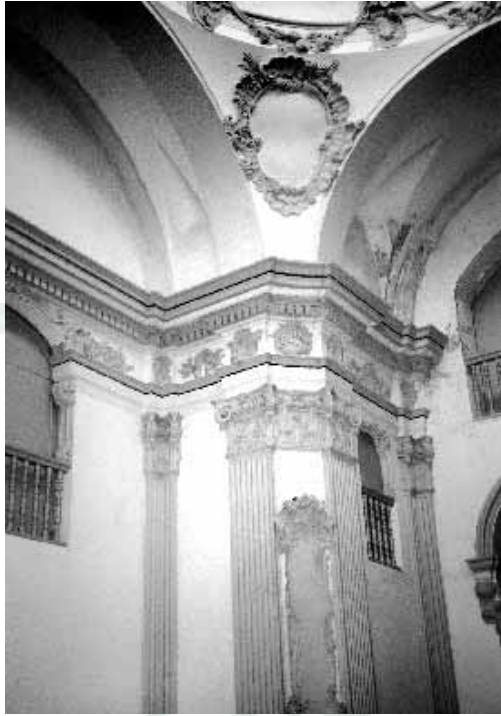
90. Interior de la capella de la Mare de Déu de l'Incendi (Cervera).
