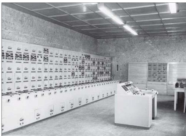
Analizator elektroenergetskih omrežij na inštitutu
