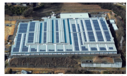
ソーラーパネル(武蔵丘車両検修場)
