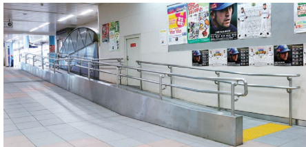
スロープ(本川越駅)
