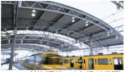
VOC対策(亜鉛メッキ処理・池袋駅)
