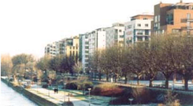
Das Deutschherrnufer hat sich in den letzten Jahren rasant entwickelt.
