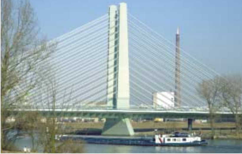
Die Sindlinger Werksbrücke über den Main.
