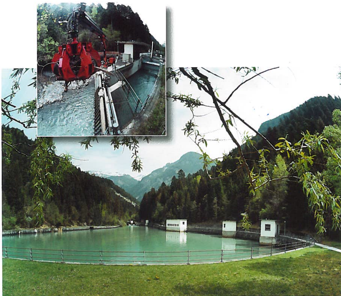
Bassin de Croix et installation de dégrillage
