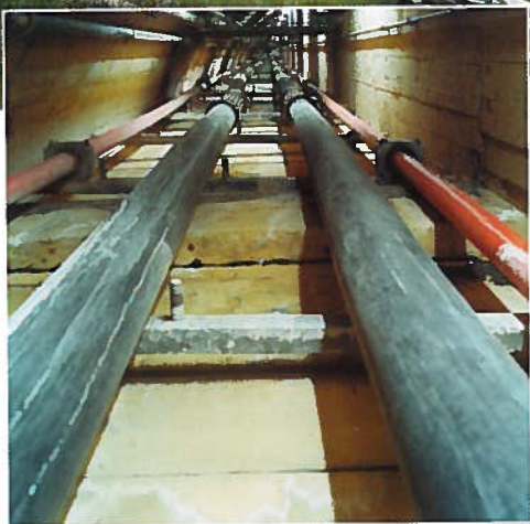
Puits d'amenée des câbles
