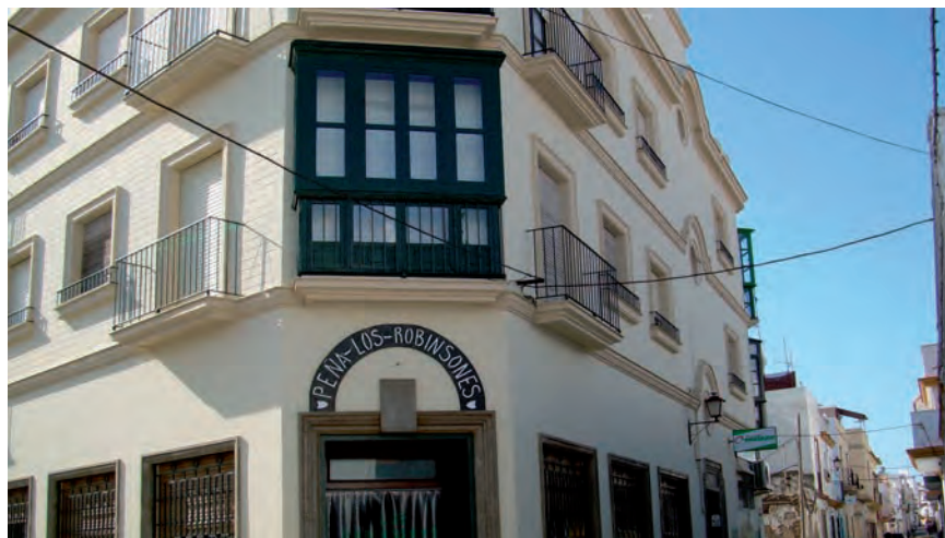
Fachada de vivienda en Calle Calvo Sotelo 50
