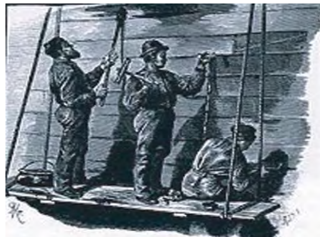
Dibujo del calafetado de un barco.
