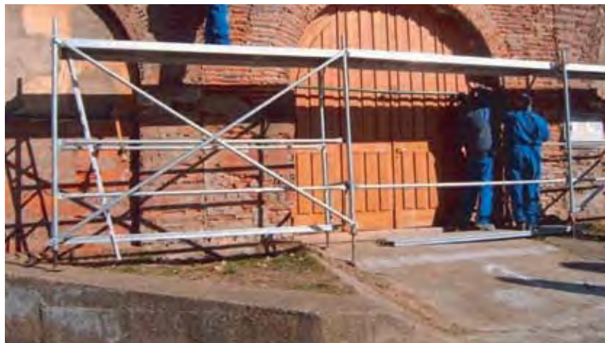
Restauración de una iglesia
