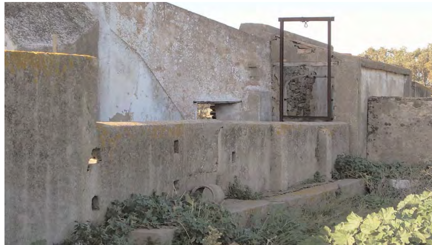
Parte de los almacenes del Cortijo Pericón.
