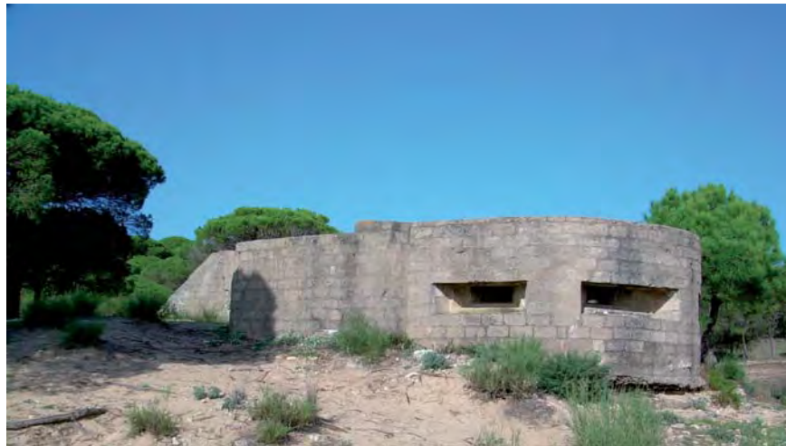
Bunker de la Breña de Barbate, declarado BIC
