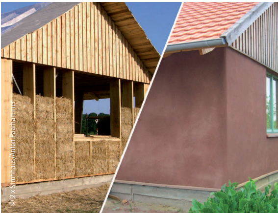
Strohballen ohne und mit farbigem Putz
