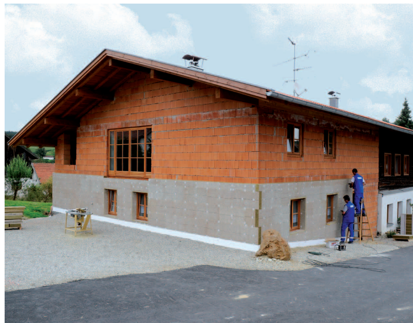
Außendämmung mit Holzwole-Dämmplatte
