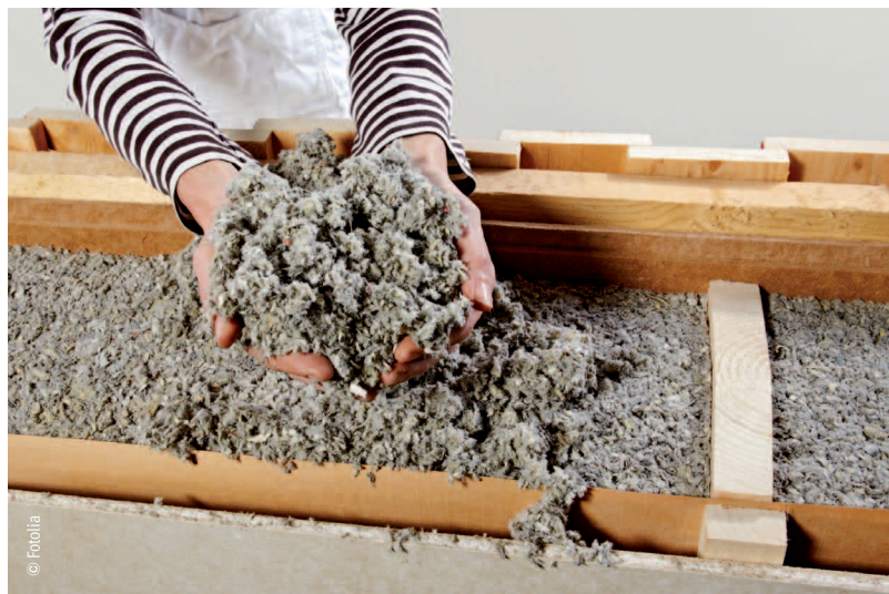
Zelluloseeinblasdämmung in einer Außenwand
