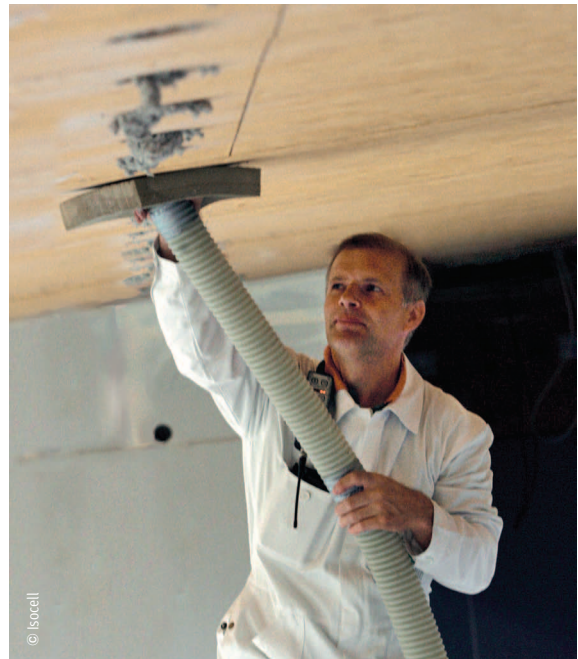
Zelluloseeinblasung in der Decke
