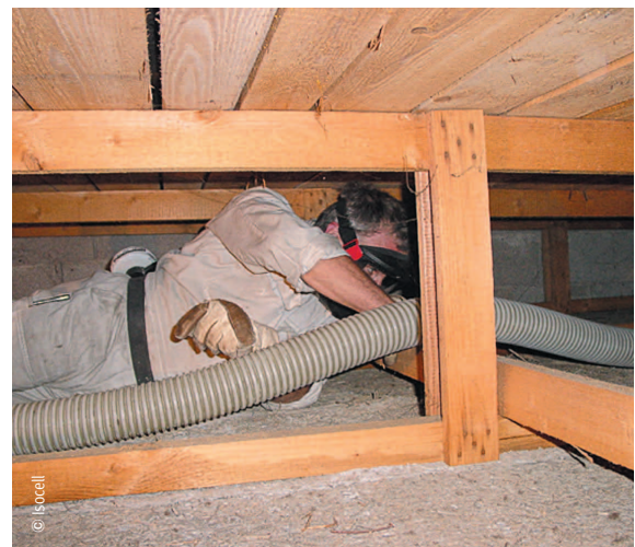
Vorbereitung zum Einblasen des Dämmstoffes
