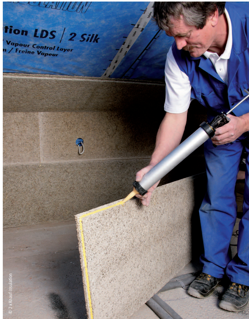
Montage der Holzwole-Dämmplatten im Innenbereich
