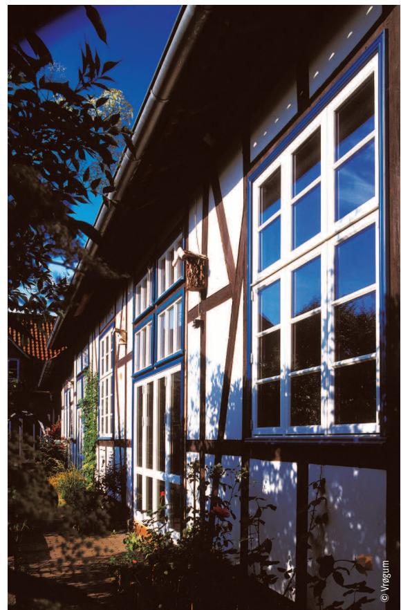
Fachwerkhaus mit Innendämmung
