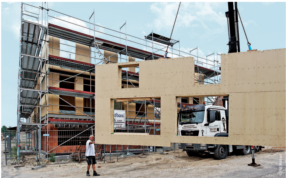
Vorgefertigte Außenwandelemente mit Holzfaserdämmung
