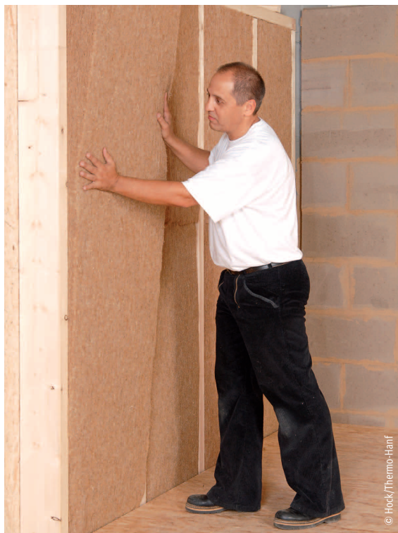
Einbau einer flexiblen Hanfdämmmatte
