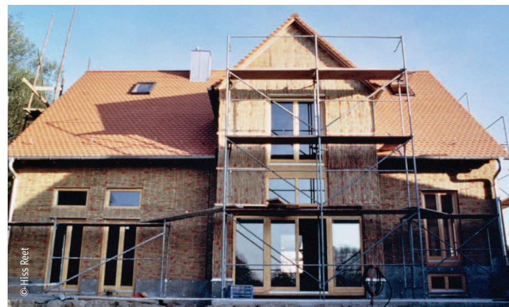
Schilf als Putzträger an der Außenfassade
