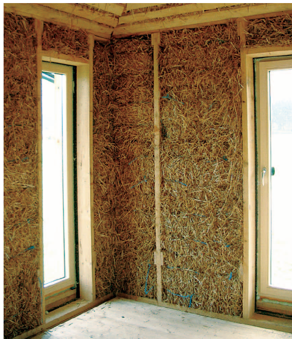
Innenansicht einer Holzrahmenkonstruktion mit Strohballendämmung
