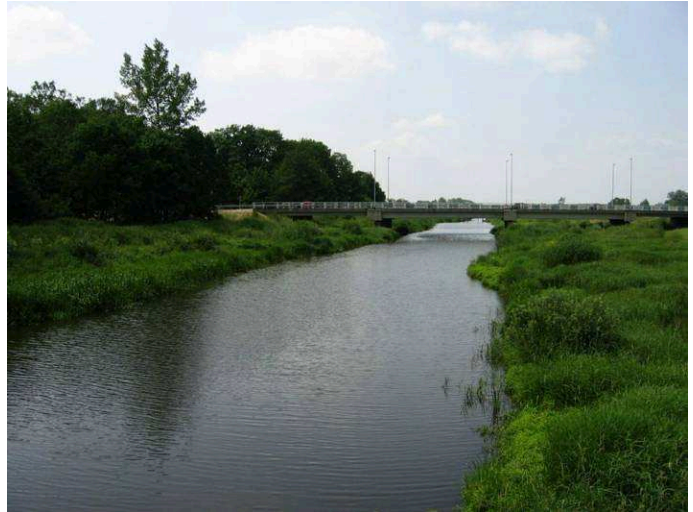
Żmigród - widok na most drogowy
