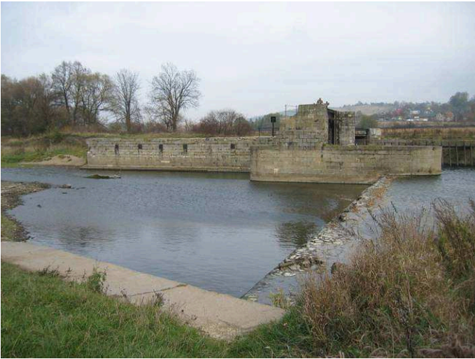
Jaz pod Kłodzkiem, obok oczyszczalni ścieków
