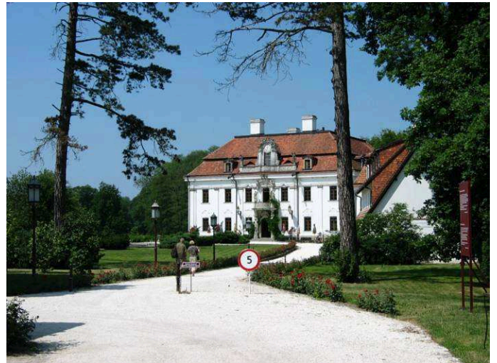
Krasków - Hotel Fundacji Rodziny Krasków
