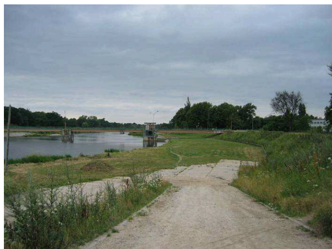
Wrocław - Grobla Szczytnicka - widok na kładkę dla pieszych
