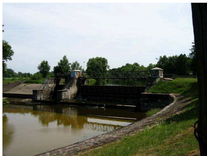
Włodzice Wielkie - śluza przy elektrowni wodnej
