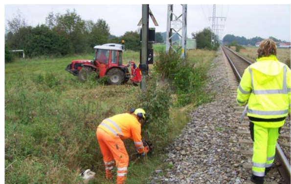
Abb. 36 Bearbeitung einer Strecke in der Pflege Quelle: DB Fahrwegdienste/ Ulrich Owara
