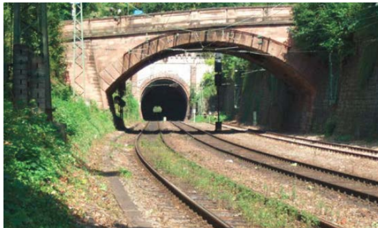
Abbildung 9 Südportal des Pforzheimer Tunnels mit der Hachelbrücke im Vordergrund, Quelle: DB Projektbau GmbH
