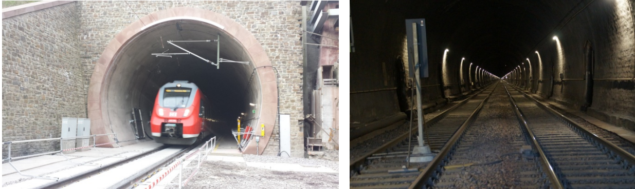
Abbildung 15 Portal des neuen Kaiser-Wilhelm-Tunnels mit dem erstem Zug nach der Inbetriebnahme am 07.04.2014 (links) und Blick in den alten Kaiser-Wilhelm-Tunnel vor Ausbau der Ausrüstungstechnik und der Fahrbahn (rechts), Quelle: DB Netz AG
