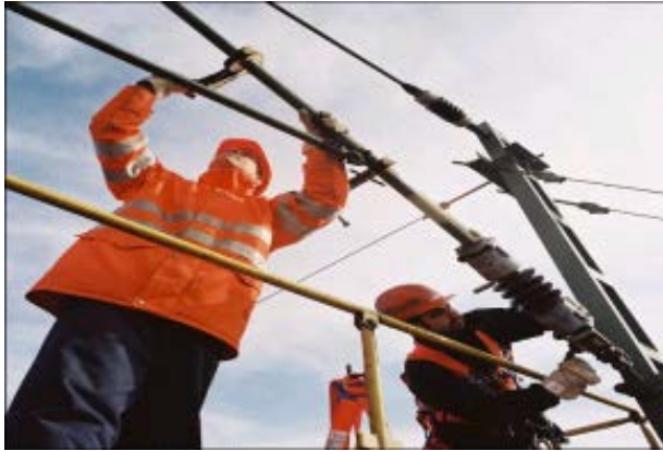
Abb. 2 Arbeiten an der Oberleitung Quelle: DB AG/Max Lautenschläger
