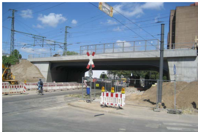
Abbildung 6 Erneuerte EÜ Seehofstraße, Quelle: DB Netz AG
