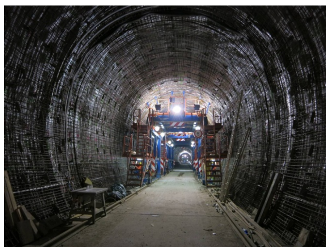
Abbildung 10 Schalwagensystem im Alten Bebenroth-Tunnel, Quelle: DB Projektbau GmbH
