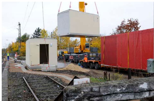
Abbildung 3 Baustellenmontage des ESTW Modulgebäudes in Hasenwechsel, Quelle: DB Netz AG
