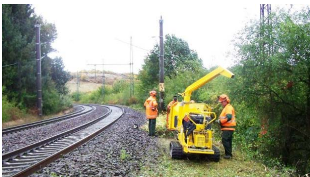
Abb. 35 Einsatz eines mobilen Hexler in der Pflege Quelle: DB Fahrwegdienste/ Ulrich Owara
