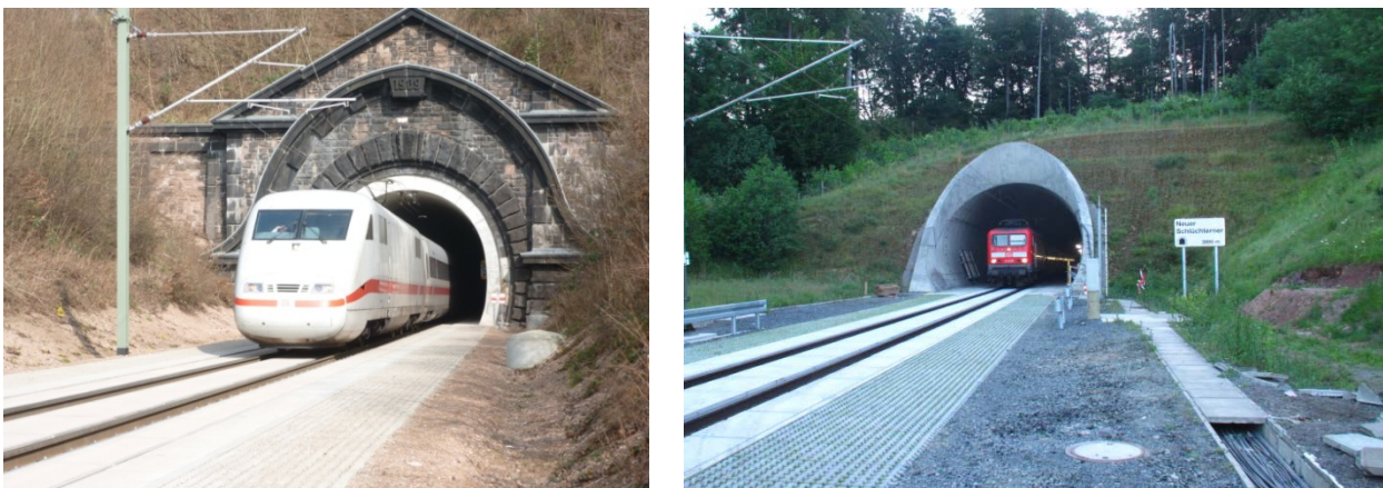
Abbildung 16 Inbetriebnahme des erneuerten alten Schlüchterner Tunnels am 01.03.2014 (links) und des neuen Schlüchterner Tunnel nach Herstellung der Eingleisigkeit am 09.06.2014 (rechts), Quelle: DB Netz AG
