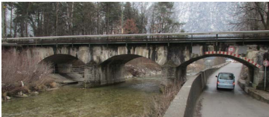
Abbildung 5 EÜ Kieferbach vor Durchführung der Baumaßnahme, Quelle: DB Projektbau
