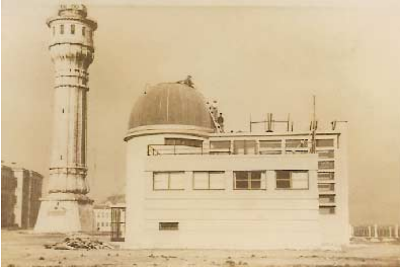
Resim 6. İ.Ü. Gözlemevi inşaatının uzaktan görünümü.
