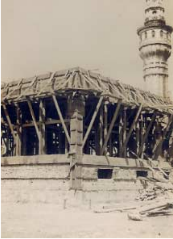
Resim 2. İ.Ü. Gözlemevi inşaatının görünüşü. Resimde tarihi Kule de yer almaktadır.
