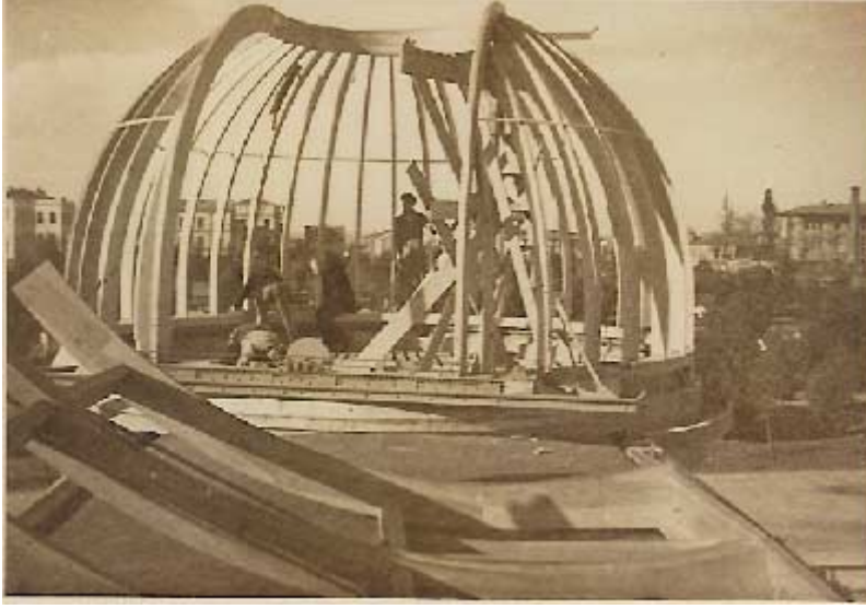
Resim 5. İ.Ü. Gözlemevi Kubbesi inşaatı.
