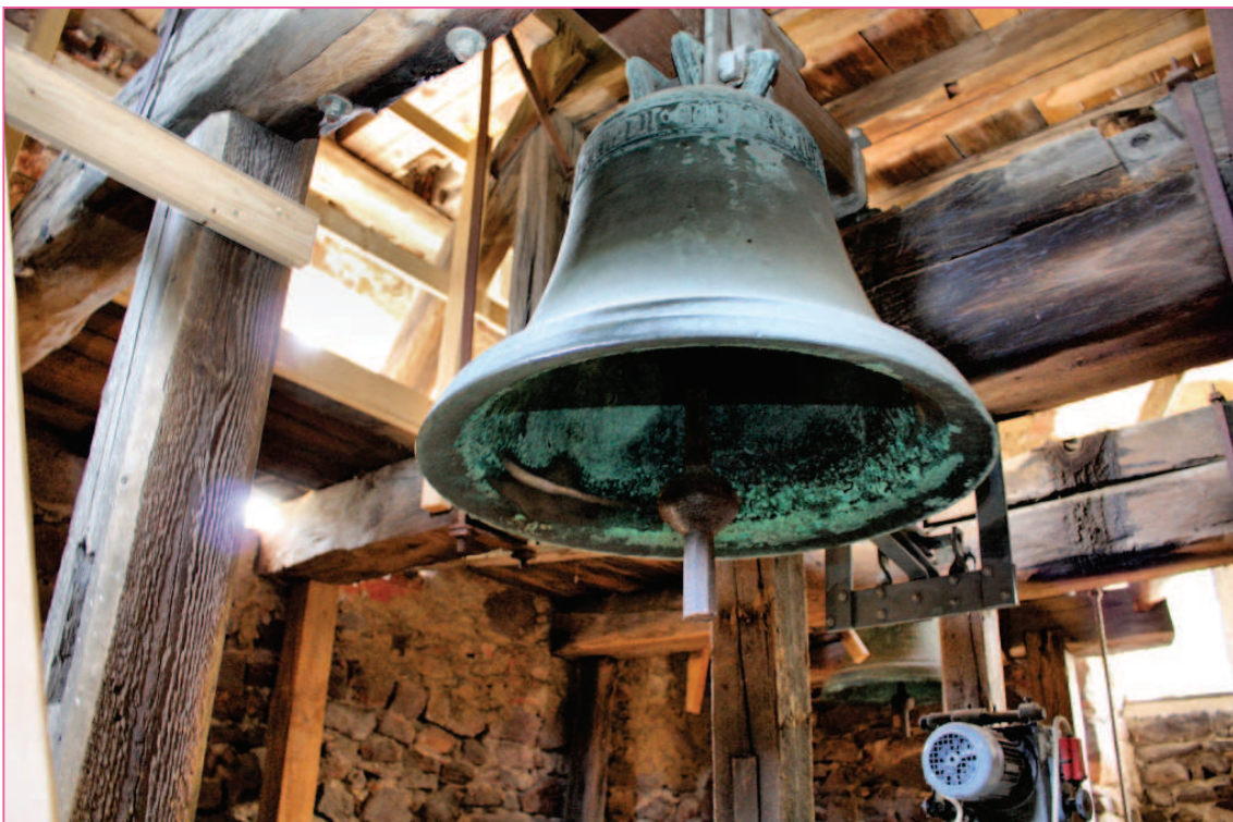
Die Glocke, die vom Uhrwerk angeschlagen wird - rechts unten der Elektromotor
