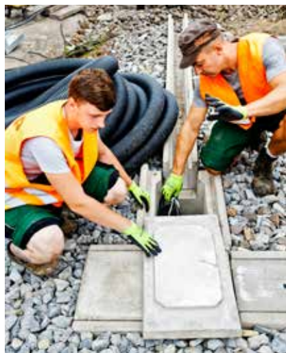
Allein am Bundesplatz werden sechs Weichen und beide Bahnsteiggleise erneuert.
