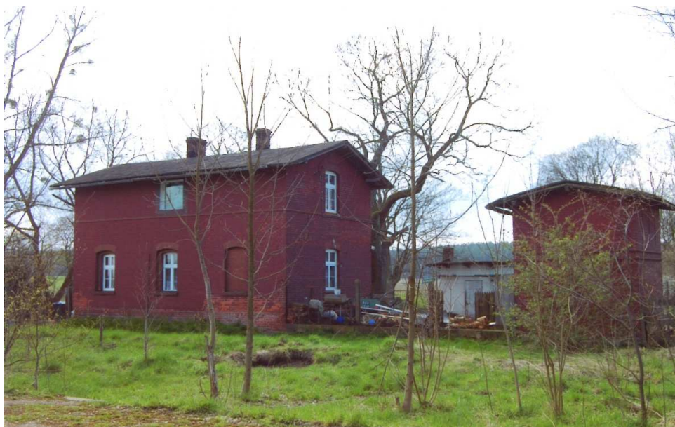
Fot.7. Dom Dróżnika w zespole stacji kolejowej ( przy lokalnej drodze do Podgórze).
