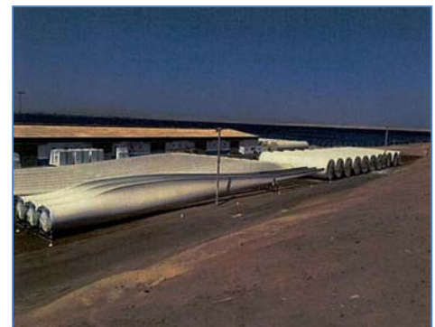
Palas y tramos de torre en la zona de obra
