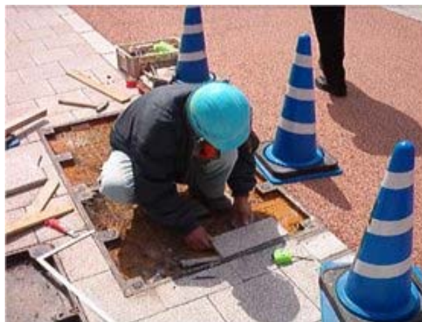
Fig.30 Posa in opera di un marciapiede
