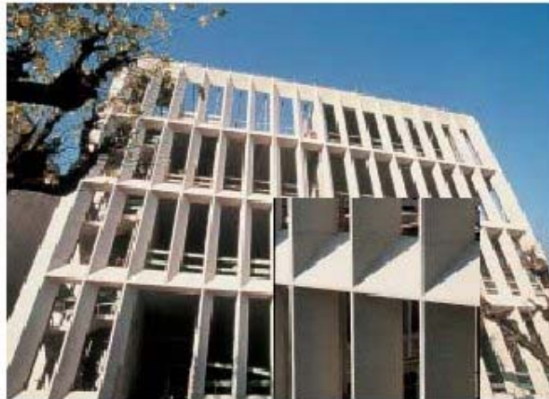
Fig.36 Veduta della facciata e particolare strutturale della Città della Musica e delle Belle Arti di Chambéry (Francia)
