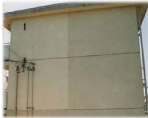
Fig.34 Palazzo semirivestito con \text{TiO}_2
