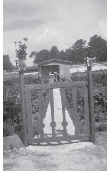
Kuva 15. Valokuva alkuperäisestä puu- rakenteisesta portista 1930-luvulta. HKA
