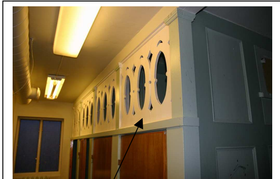
Utskjæringer over gutttoalettene
