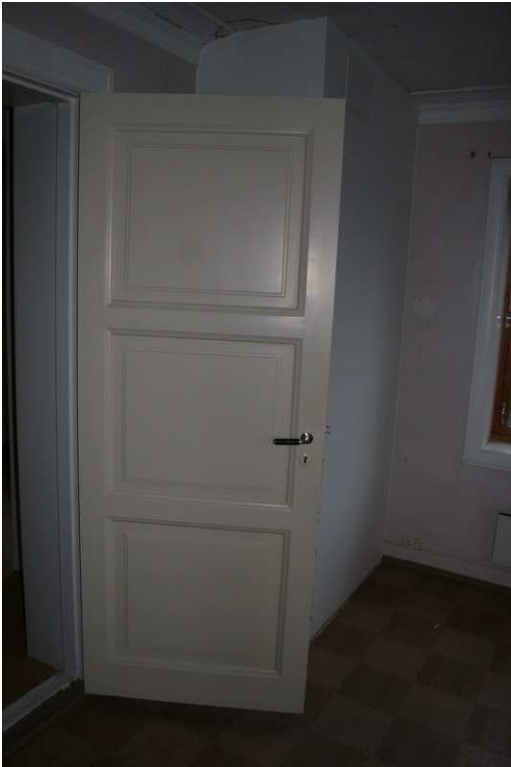
Dør, 2. etasje i vaktmesterbolig
