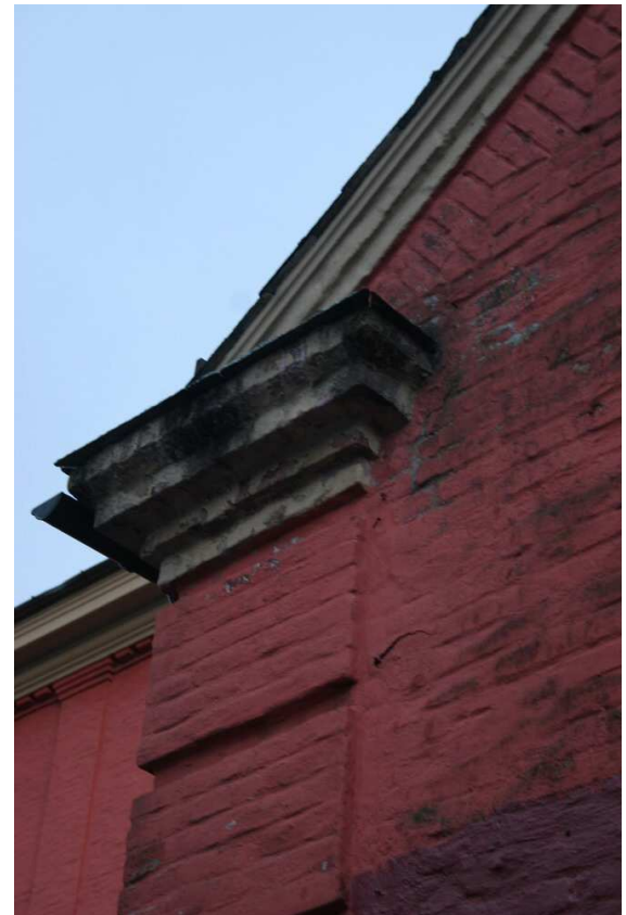
Detalj av pilaster og kapitel, i klassiserende uttrykk. På fasade mot gårds plass.
