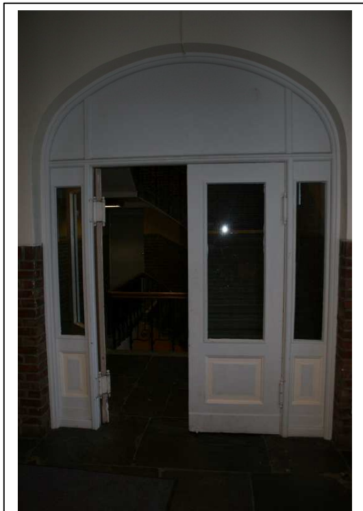
Dør i korridor
