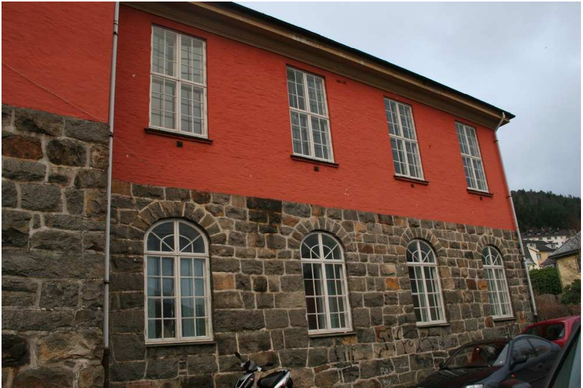
Fasade mot Rogagaten. Gymsal; legg merke til de store vinduene i begge etasjer som gir gjennomgående lys.
