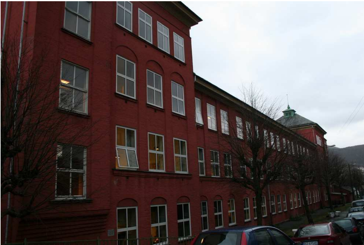
Fasade mot Møregaten
