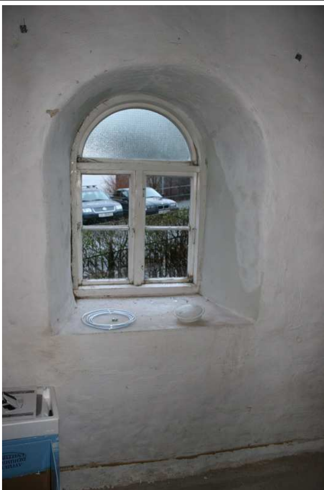
Kjellervindu i vaktmesterbolig
