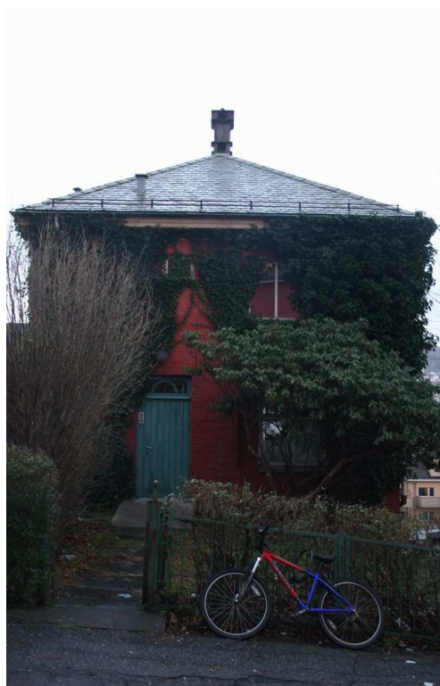
Inngangspartiet til vaktmesterbolig
