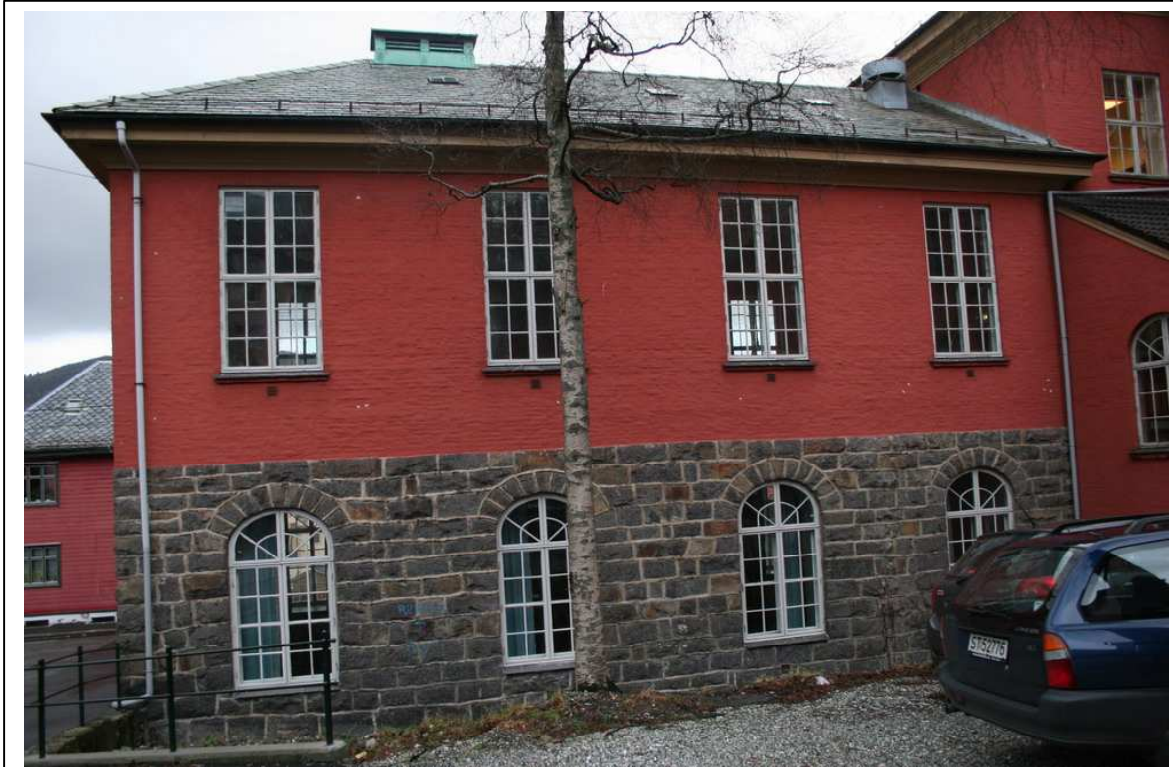
Bakfasade på gymsal mot parkeringsplass.
