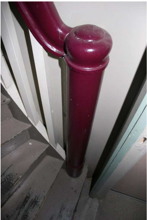
Detalj av trapp
