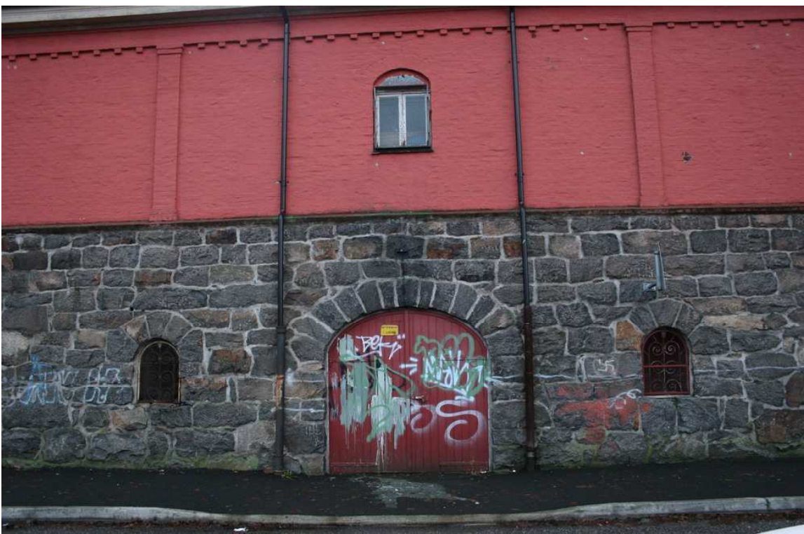
Del av fasade mot Rogagaten. Her kan vi tydelig se den rustike sokkeletasjen, pillastrene og tannsnittbården.
