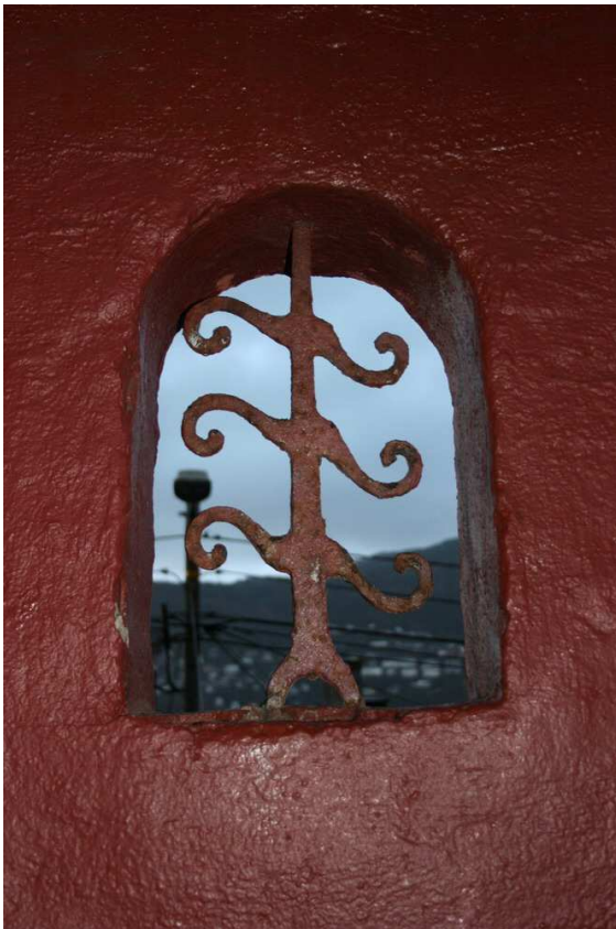
Glugge i veggen på innsiden av uværsskuret med smijernsarbeid, vender mot Rogagaten.
