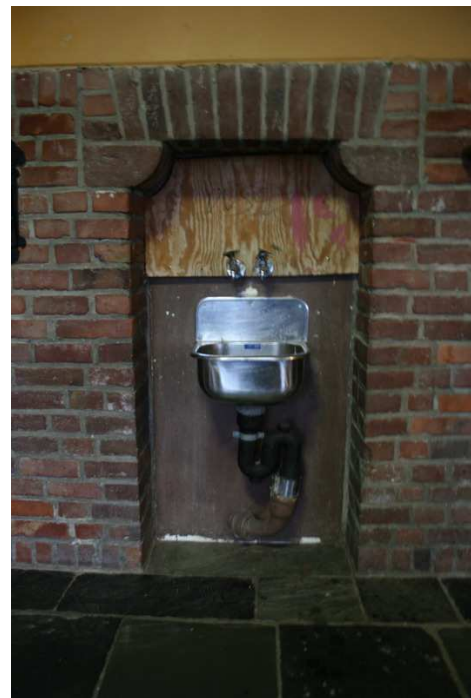
Innhukk i korridor, original drikkefontene erstattet med ny.
