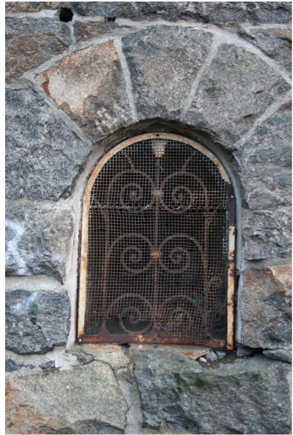
Buet åpning med smijernsarbeid i grunnmur på fasade mot Rogagaten.
