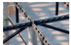
Abb. 43: Deckenträger im Auflagerbereich. Steglöcher und Gewindestange sichern den Verbund mit dem Ortbeton.
