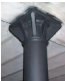
Abb. 10: Brandschutzanstrich bei einer historischen Gussstütze im Zürcher Löwenbräu-areal: Feuerwiderstand 60 Minuten
