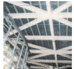
Abb. 15: Fachwerkkonstruktion eines Messegebäudes mit Brandschutzverkleidung (Promat AG)
