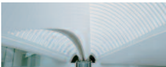
Abb. 12: Kuppeldach der Universität Zürich: Hohlkastenprofile mit Brandschutzanstrich R 30 (Stucortec AG)
