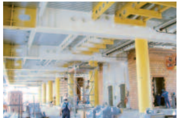
Abb. 40: Deckentragwerk Stahl-Beton-Verbundbau, teils mit Brandschutzanstrich R 60, ungeschützte Sekundärträger dank Membranwirkung
