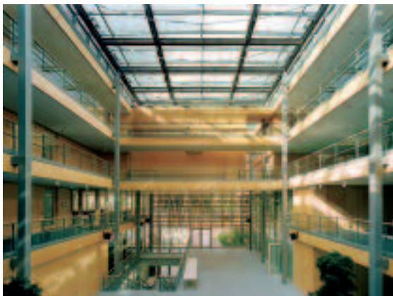
Abb. 24: Stahl-Holz-Verbundkonstruktion im Verwaltungsgebäude der Landesvertretung Nordrhein-Westfalen, Berlin
