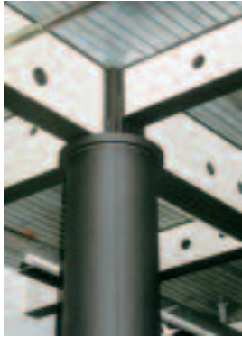
Abb. 20: Kammerbetonierter Träger auf betongefüllter Hohlprofilstütze
