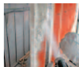
Abb. 19: Spritzputzapplikation an T-Fassadenstützen, Postgebäude Freiburg
