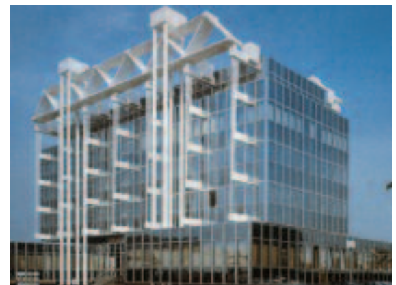
Abb. 28: Dieses Gebäude in Hannover besitzt eine wasserdurchflossene Tragstruktur. Im Brandfall zirkuliert das Wasser und kühlt den Stahl.
