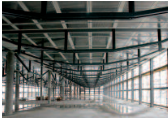
Abb. 42: Decke mit unterspannten Stahlträgern, noch ohne Installationen
