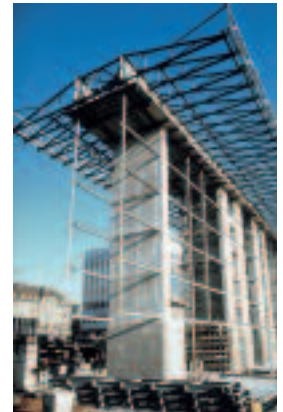
Abb. 29: Geschäftshaus in Lausanne mit aufgehängten Fassadenstützen.
