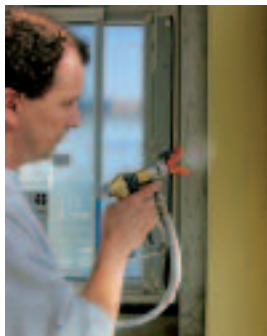
Abb. 9: Spritzapplikation an einer Hohlprofil-Fassadenstütze (Max Schweizer AG)
