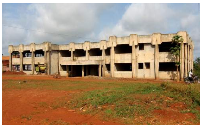
Le chantier du futur hôtel de ville de Yokadouma
