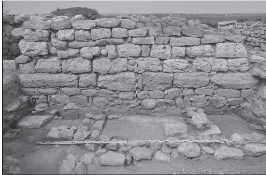
Рис. 2. Кульчук-2012. Восточная часть южного фасада башни Геракла и стены постройки предшествовавшей её строительству. Вид с юга
