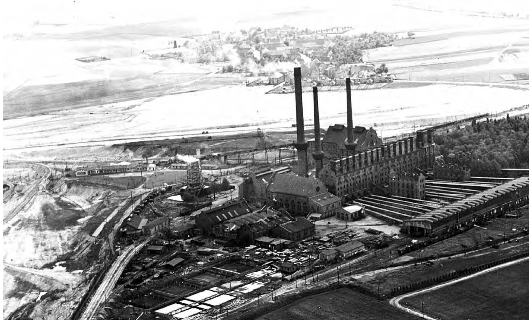
Brikettfabrik Phönix, 1920er Jahre
