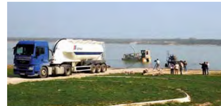
Befüllung des Sanierungsschiffes auf dem Haselbacher See, 2009 Behandlung des Stützungswassers für den Haselbacher See, 2011
