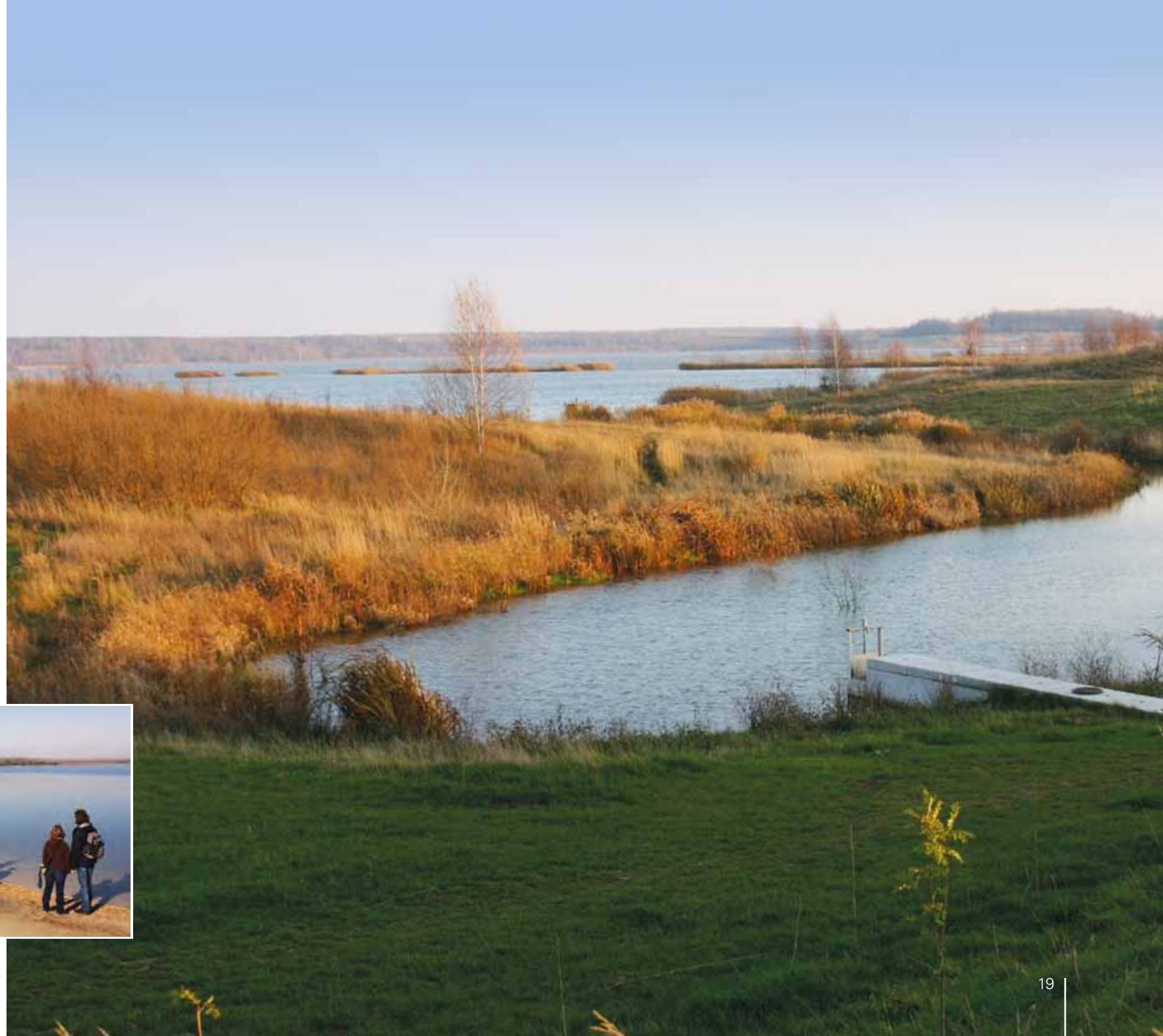
Westufer des Haselbacher Sees bei Ramsdorf (Sachsen) mit Auslauf- bauwerk in die Schnauder, 2006
