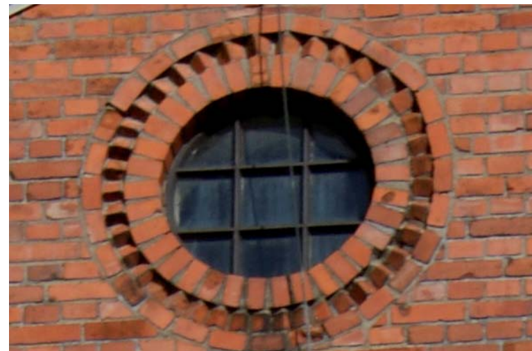
Runt gjutjärnsfönster omgärdat av sågtandsmurning högt uppe på Sockerfabriken.
