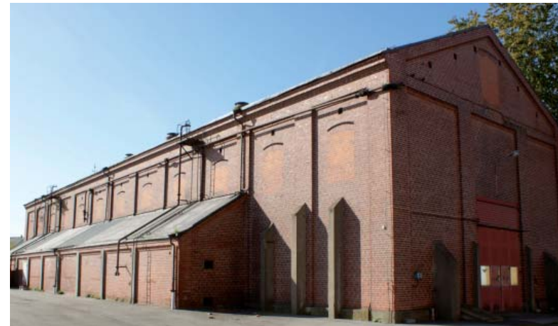
Sockerladan består av ett högt mittskepp med två lägre sidoskepp. Fasaden är vertikalt uppdelad genom ett markerat murverk med lisener och försedd med detaljer som t.ex. sågtandsskift och stickvalvmönster.
