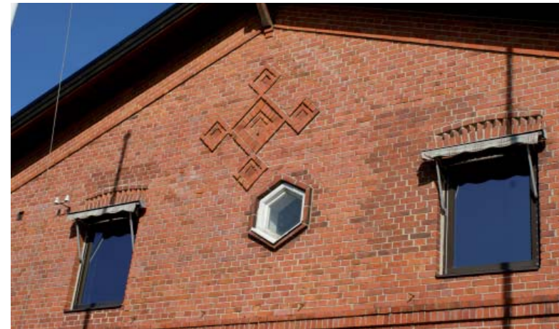
Kontorsbyggnaden vid Sockerbrukets infart har mönstermurning som dekoration på gavlarna. Fönsteröppningarna har stickvalv med ett ovanliggande sågtandsskift. Taket som kragar ut över gavelfasaden vilar på träkonsoler.
