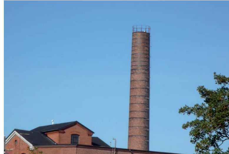
Den 50 meter höga skorstenen syns på långt håll. Den är murad med rund pipa, vilket är en följd av radialteglets introducering på 1880-talet. Till vänster syns vattentornsbyggnaden som försörjde fabriken med vatten.
