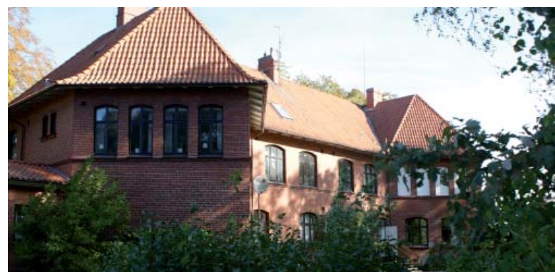
Norra Villan har ett framträdande tak, gesimser av formtegel och stickvalv över fönsteröppningarna.
