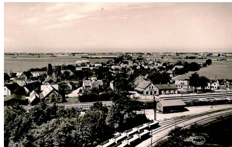
På bilden syns stickspåret från Sockerbruket till järnvägsstationen som i samband med den nya järnvägslinjen 1892 utvidgats med en tillbyggnad i två våningar.
