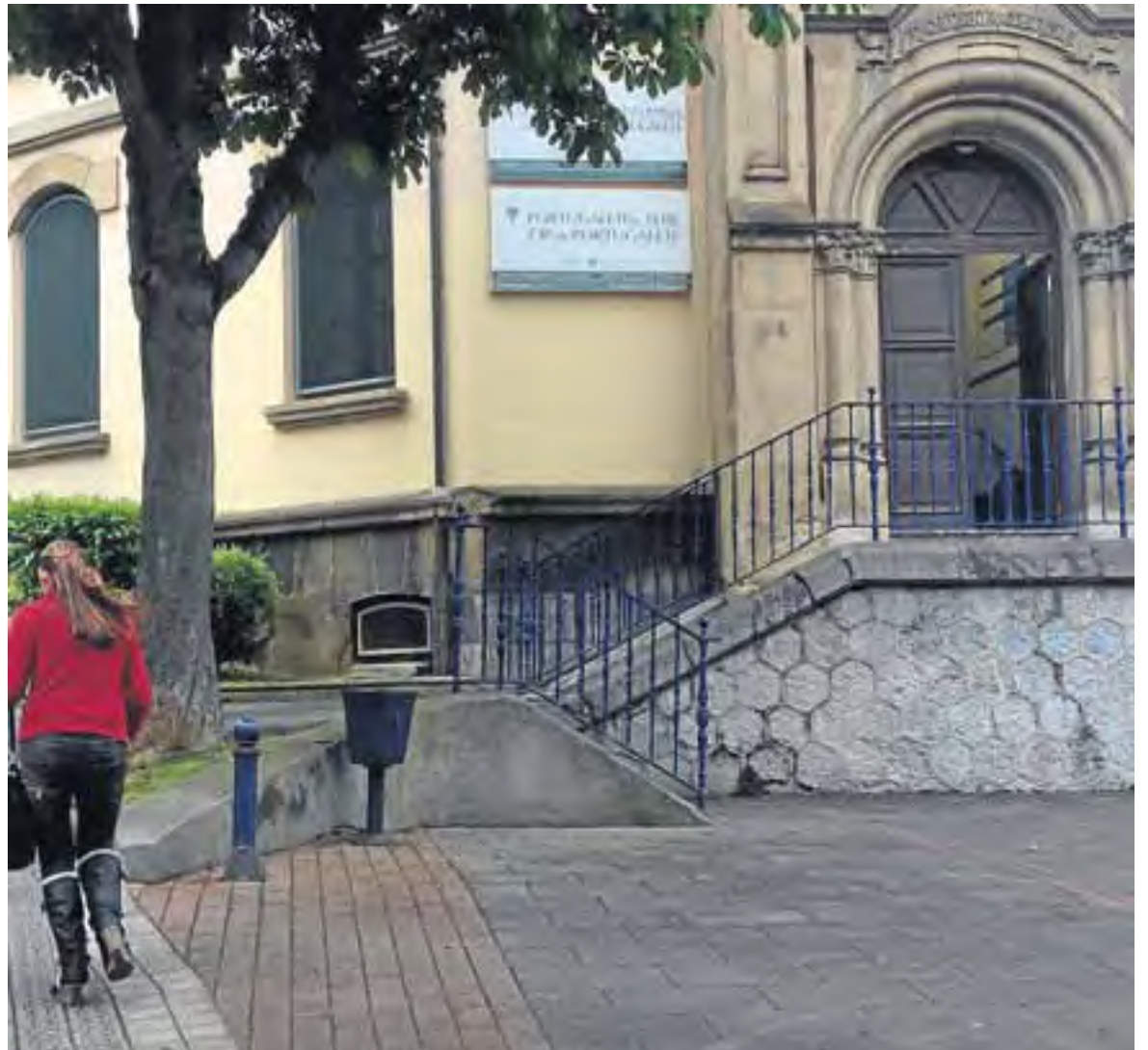
Una mujer camina junto a las instalaciones que se convertirán en albergue durante el mes de agosto. FOTO: T. R.
