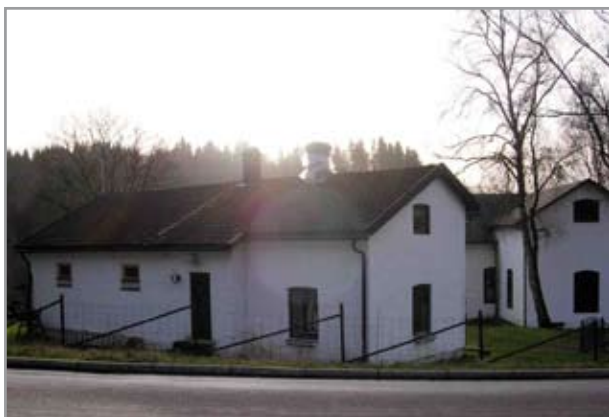
S1501 F.d. kraftstationen 1020
