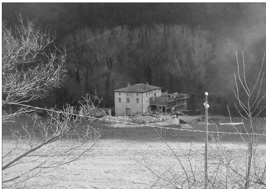
Palazzo in fase di ristrutturazione
