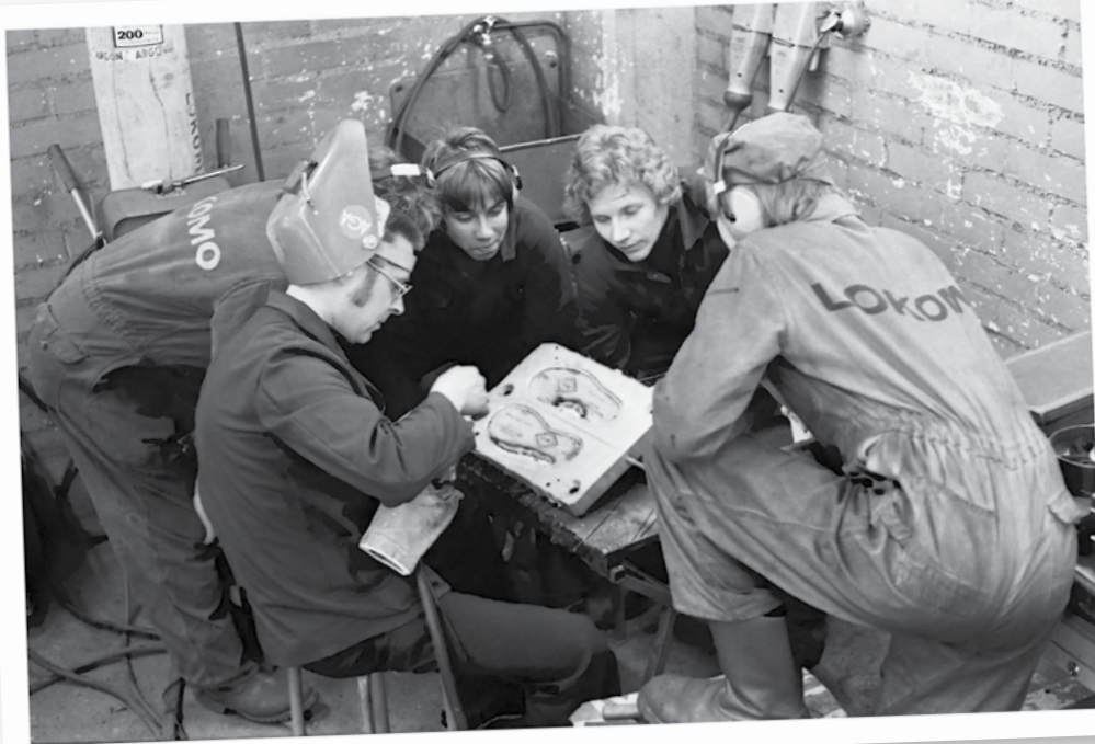
Opettaja Pekka Tolonen korjaushitsaamassa kenkämuottia vuonna 1975. Kuva Markku Nieminen.
