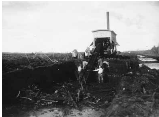
Turpeennosto käynnissä Hanhisuolla yhtiön valmistamalla turpeennostokoneella.
