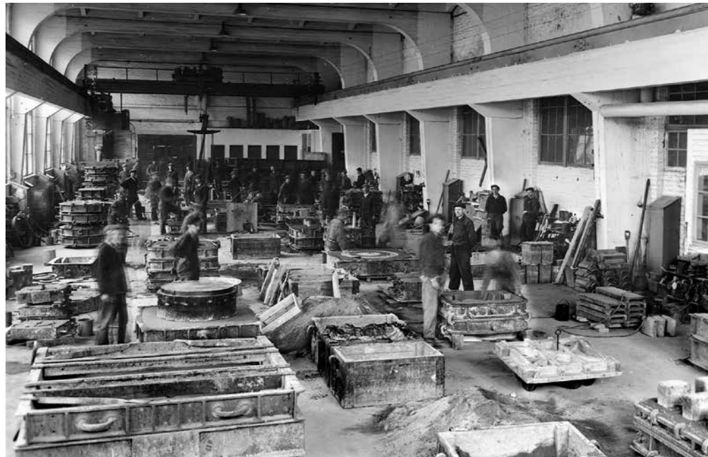
Valumuottien valmistusta todennäköisesti 1950-luvulla.
