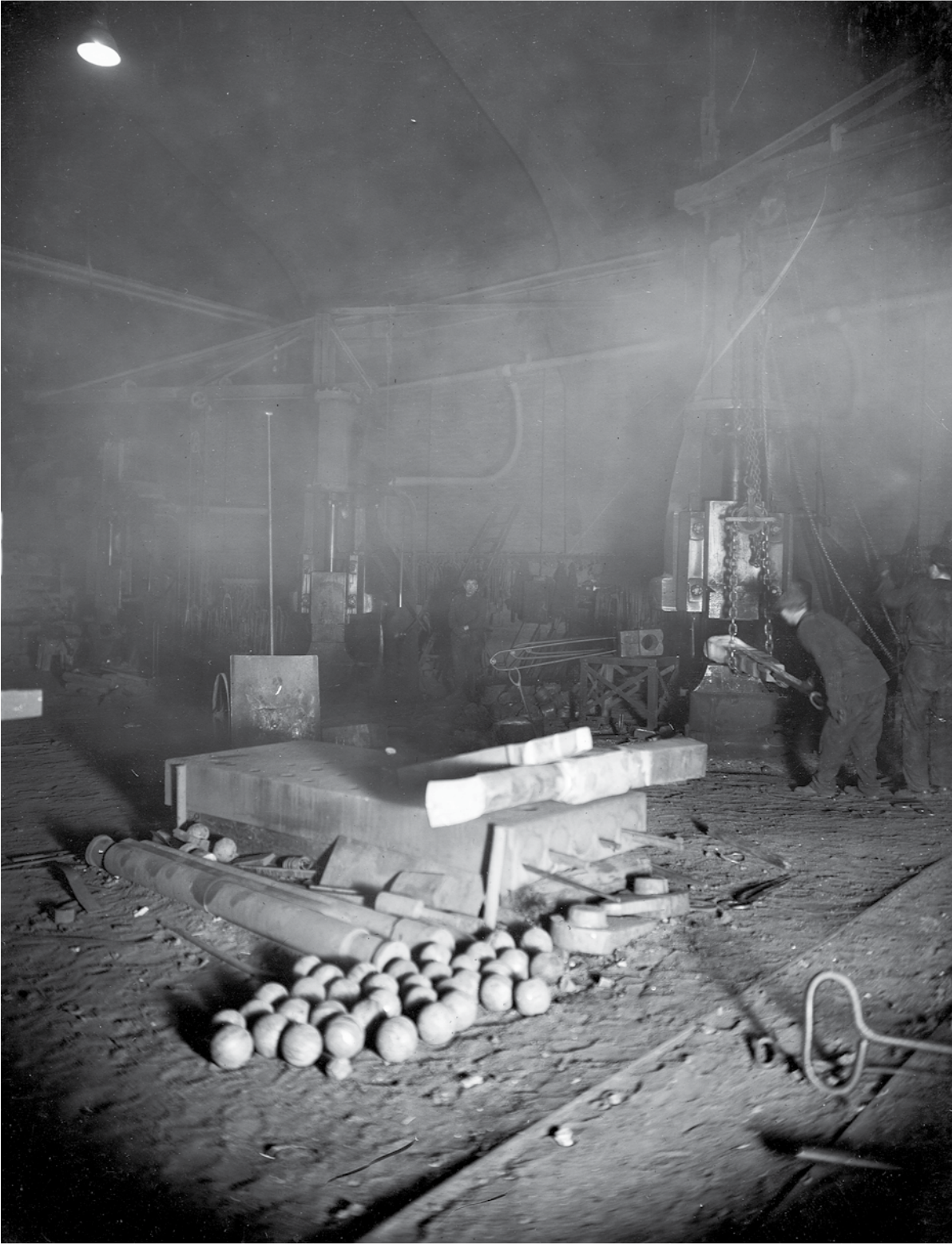
Takopajassa työt käynnissä 1930-luvulla.
