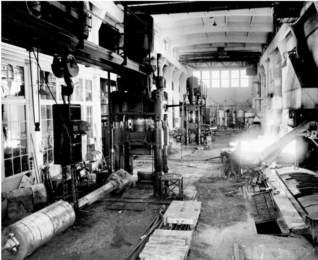
Takopuristinlaitos 1940-luvulla. Etualalla 1200 tonnin Eumuco takopuristin manipulaattoreineen; takana lämpökäsittely- altaita.
