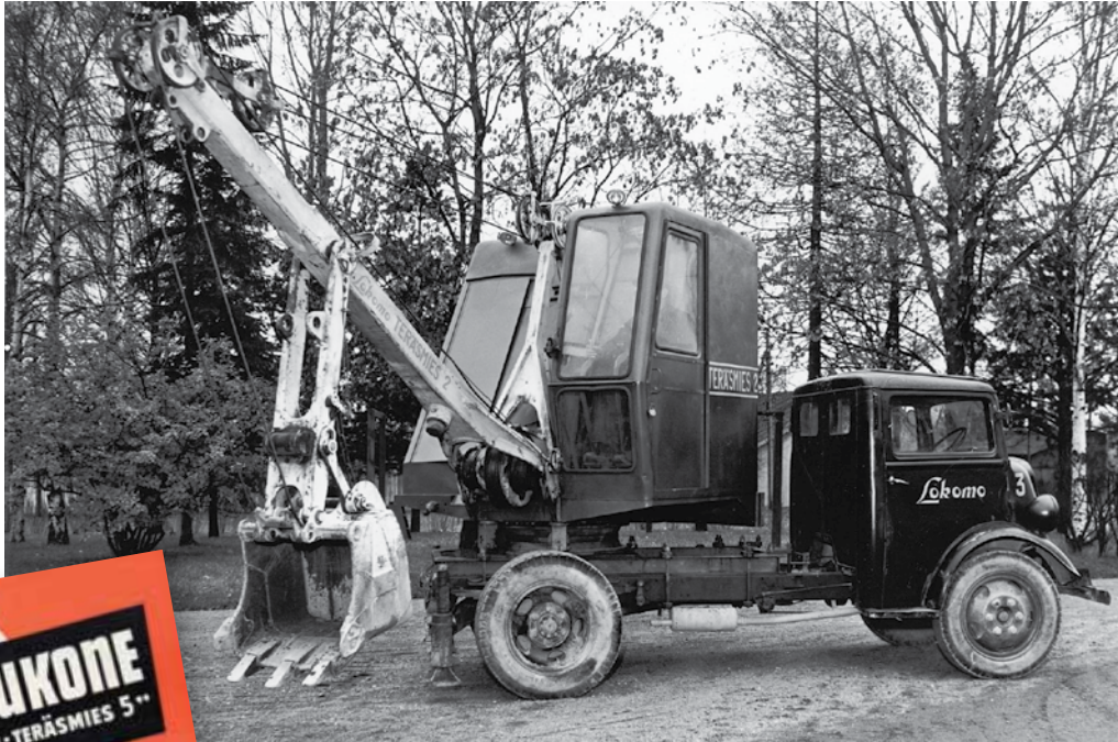
Teräsmies 2 asetettuna kuorma-auton lavalle 1950-luvulla.
