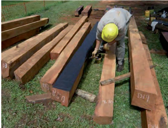
Figura 13. Preparativos previos a la colocación de los nuevos dinteles.
