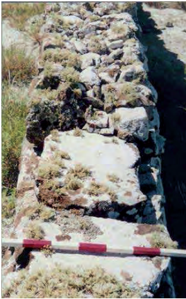
Figura 4. Vista superior del Muro 2. Nótese que en la porción inferior culmina con lajas dispuestas transversalmente mientras que en la superior se observa la disposición de muro doble con relleno de piedras pequeñas.
