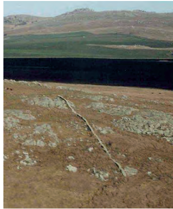
Figura 5. Vista del Muro 1 tomada desde un vuelo de baja altura
