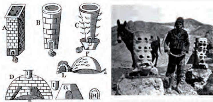
Figura 1: Tipos de hornos o wayras históricos, derecha, dibujo de Barba ([1640]:1817) y izquierda fotografía de Peele (1894).
