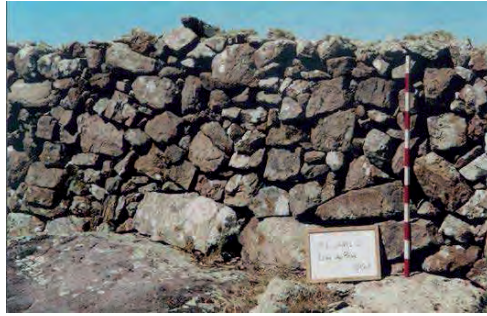
Figura 3. Vista de frente de un sector del Muro 4.
