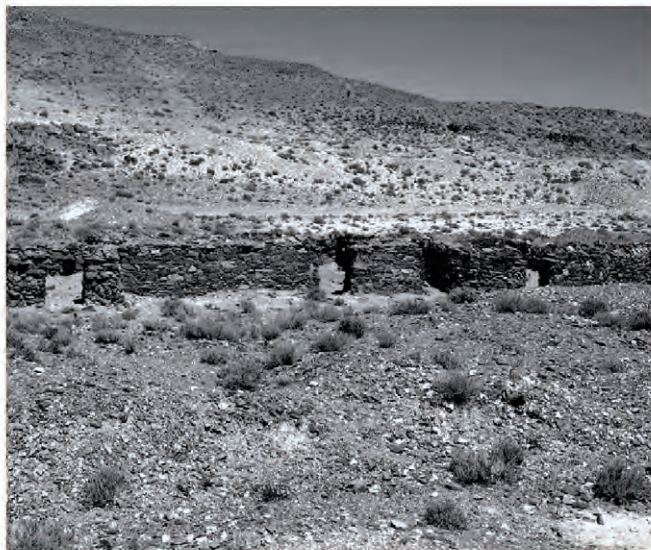
Figura 8. Área de chancado. En primer plano hay desmontes, vinculados a los piques del centro de la hoyada. En segundo plano, hay desmontes vinculados a los rajos sobre la ladera oeste.
