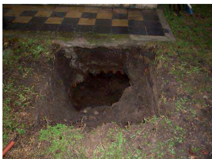
Figura 3. Excavación del techo del túnel.
