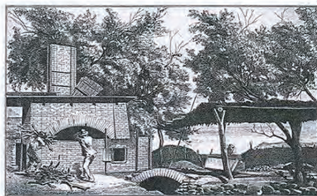
Figura 3. Horno de reverbero en Pilciao (tomado de Espeche 1875)
