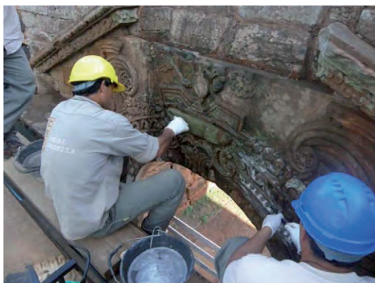
Figuras 10, 11 y 12. Portal de sacristía previo a limpieza y durante la misma. Tratamiento con productos químicos. Fuente: Documentación Obra Puesta en Valor 2009-2010
