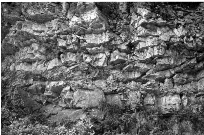
123. kép. Réteglap menti csúszással breccsásan összetört és kiékelődött mészkőpadok a Gerennavári Mészkőben. A Gerennavár É-i oldalán a Nagy-fennsíkra vezető erdészeti műút lementszésében
