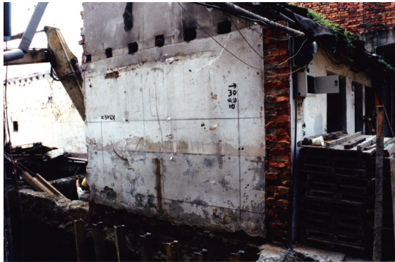
建坪不大的大陳新村舊屋拆除重建工事
