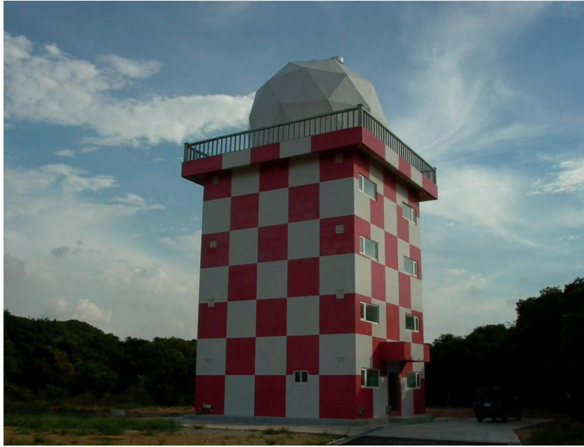
圖 1、桃園國際機場新都卜勒氣象雷達外觀，上方白色球體為雷達天線罩。
