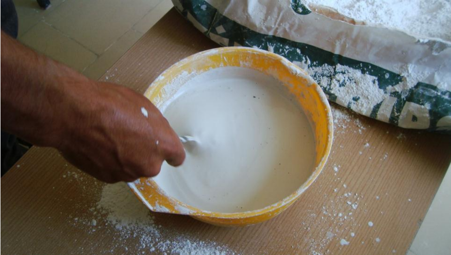
A gipsz keverése, levegőbuborékok eltávolítása
