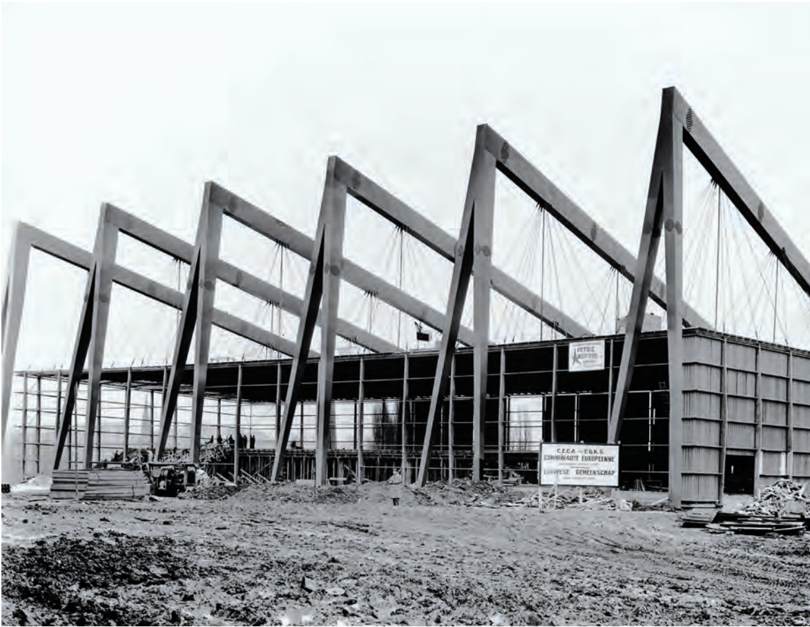
Pavillon de la CECA à l'«Expo 58» conçu par les architectes Eugène Delatte et Robert Maquestiau.
