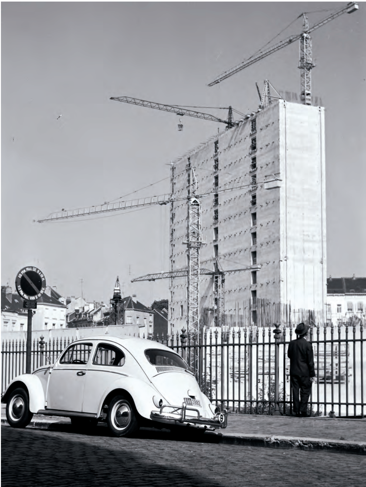
Bruxelles, 30 septembre 1964, le bâtiment Berlaymont en construction. L'édifice est bâti aile par aile. Prévue pour 1964, la première aile ne sera achevée qu'en 1967. La direction générale de l'agriculture s'y installera.
