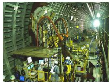
곡선 파이프루프 시공 장면
