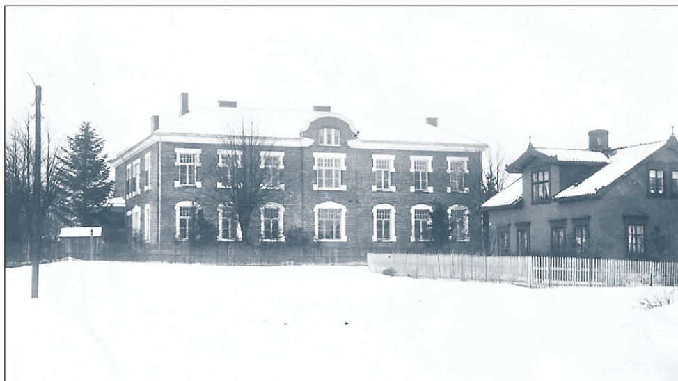
Sykehuset sett fra Greveveien og nordover.
