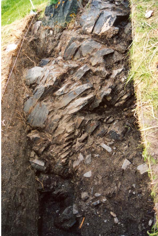
Foto B13: Nordveggen, som består av naturlig berg. I venstre nedkant av bildet er bunn av sjakta nådd, i høyre nedkant av bildet gjenstår noe masse før bunn nådd. Bildet tatt mot N.
