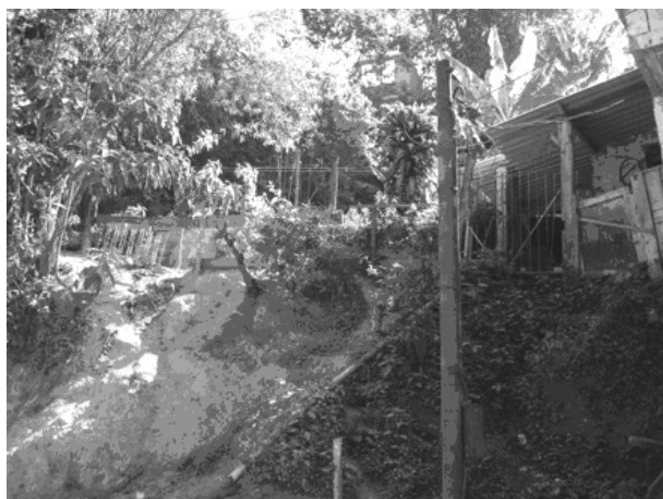
Jd. Spada - área de risco encosta
