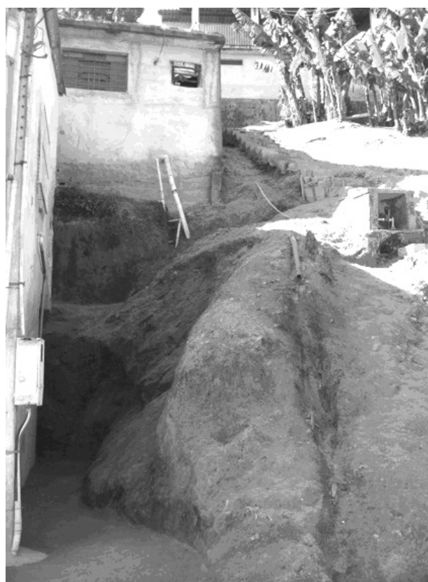
Jd. Santana - área de risco de deslizamento
