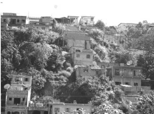
Jd.Carpe - deslizamento de encosta
