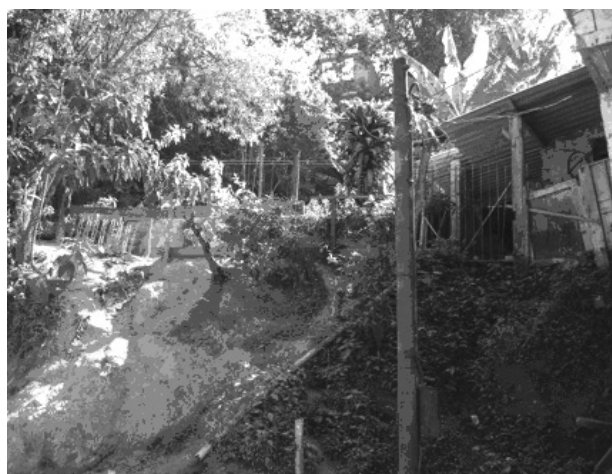
Jd. Spada - área de risco encosta
