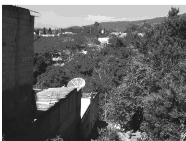
Jd. Spada - área de risco encosta, área mais crítica
