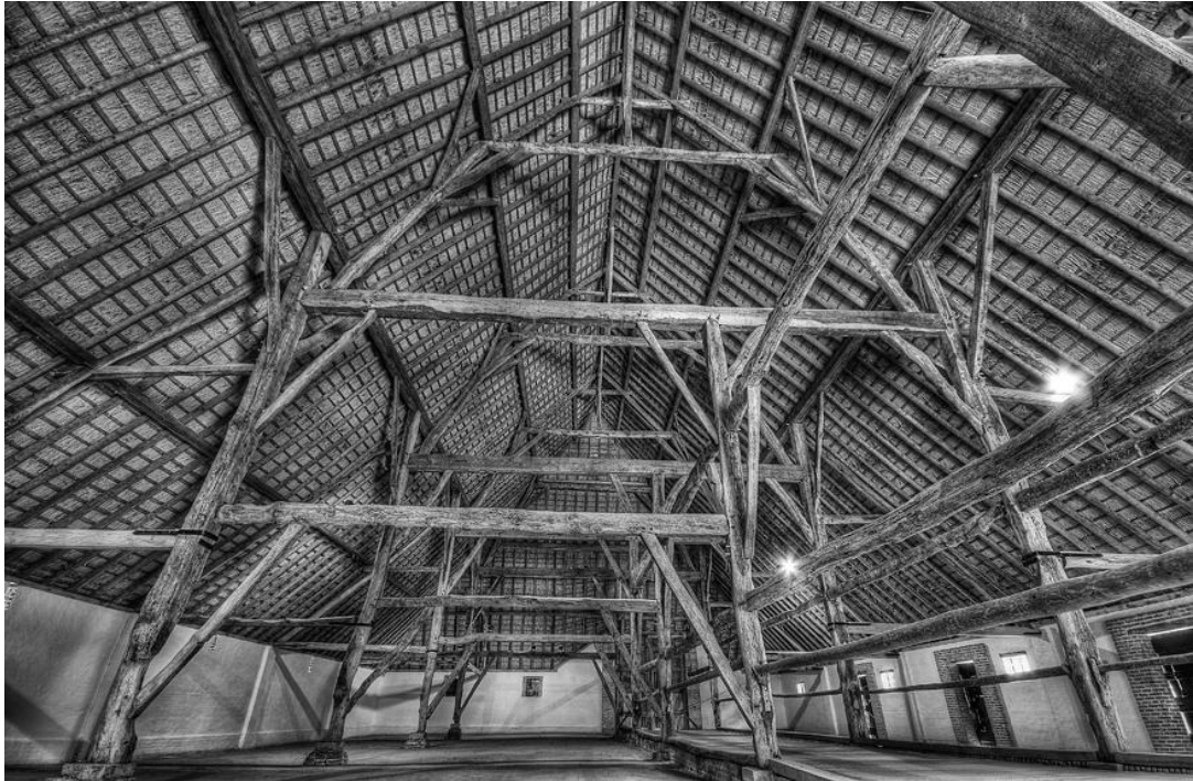
Figuur 7-34 Schuur van Oorderen (Bokrijk): gebinte
