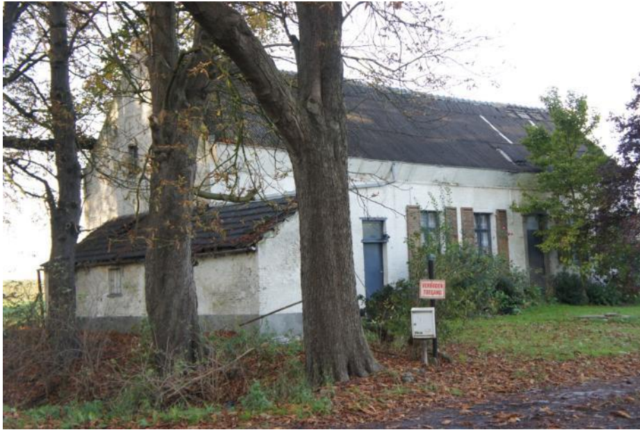
Figuur 7-73 Hoeve Westlangeweg nr. 1 (eigen foto)
