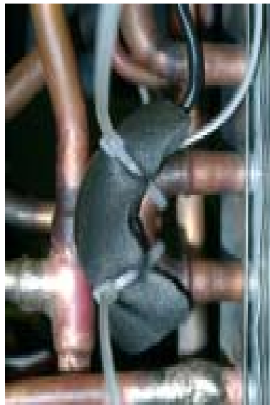
Фото 5. Дополнительная теплоизоляция повышает точность показаний сенсора
