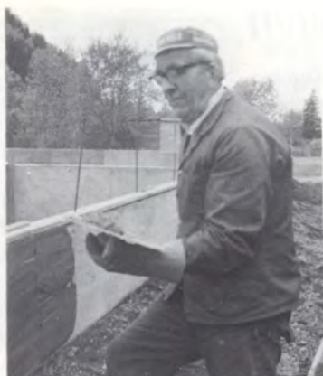
Ivar Holand pusser grunnmur.
