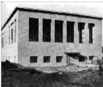
Waschanstalt der Siedlung während der Bauzeit
