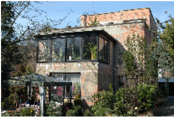
Zustand der Villa Liebig 2005
