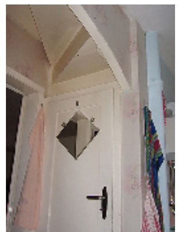
Detail Kellertür und Treppenaufgang in einem Doppelhaus, 2007
