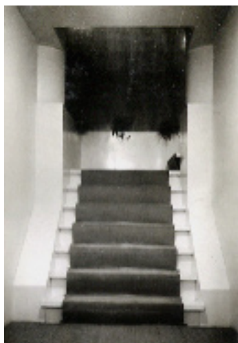
Aufgang zur Wohnhalle
