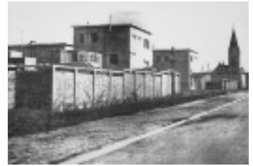
Blick in die Knarrbergsiedlung nach Baufertigstellung
