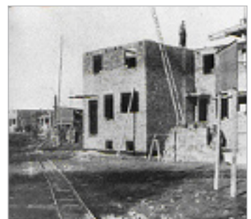
Die ersten Häuser der Siedlung „Zickzackhausen“ entstehen im Jahr 1928.
