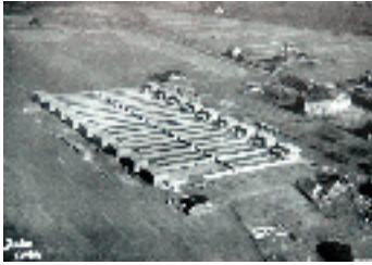
Luftbild des ersten Bauabschnitts
