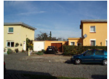
heute als Garagen genutzter Bereich zwischen zwei Doppelhäusern, 2007
