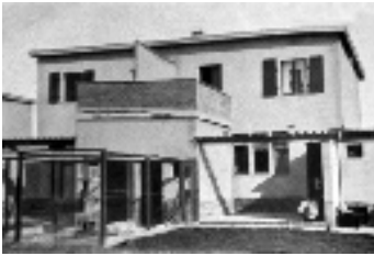
Ansicht der Gartenseite eines Doppelhauses in der Siedlung Köthen-Geuz, um 1930
