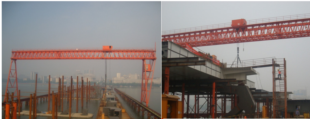
图例：使用“基于龙门吊的内湖梁式钢桥安装技术”的武汉八一路延长线光谷大桥项目施工现场
