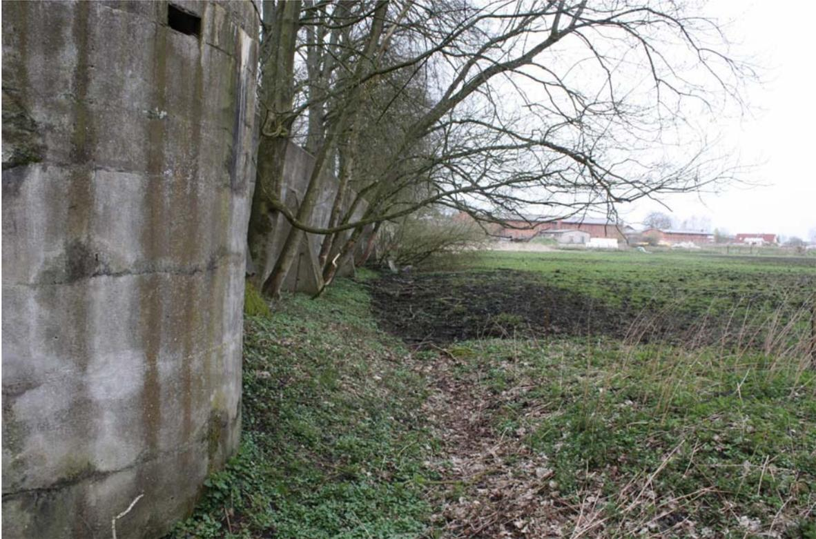
*Abbildung 10: Die östliche Mauer mit Schiefstand und erheblichen Rissen. (2009)*
