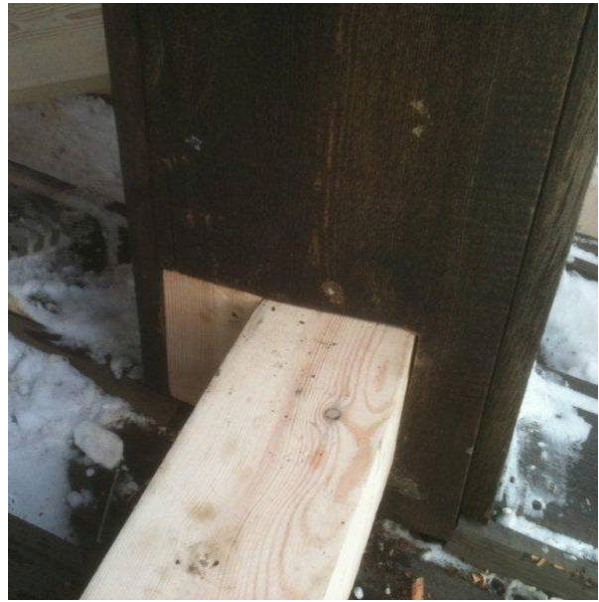
För att komma åt att få dit den nya bjälken fick en bit av inklädnaden plockas bort och kompletteras med ny bit
