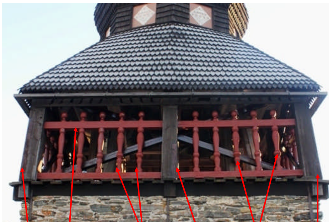
lagning ny bjälke nya balusterdockor lagning nya balusterdockor lagning
