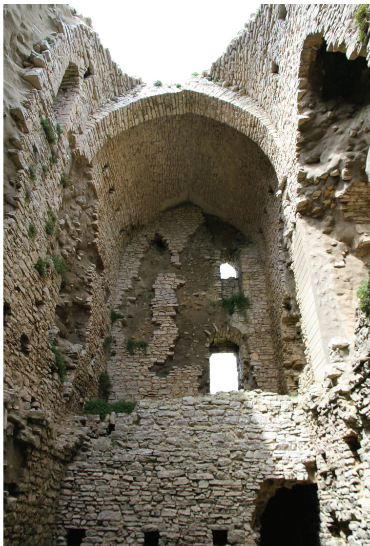
Fig. 7: Interno della torre “Mastra” con tracce di collocazione dei solai in legno.
