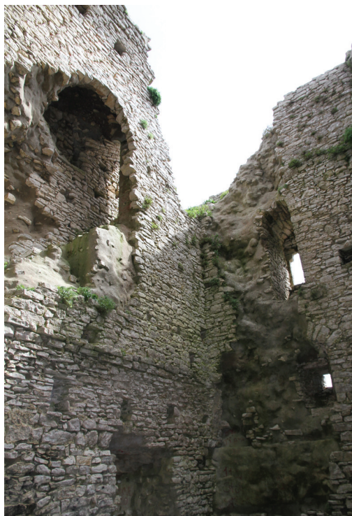
Fig. 5: Interno della torre "Mastra": particolare dello spessore della muratura assottigliata nei lati E e N per la collocazione della scala.
