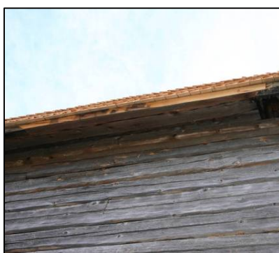
Del av nedre taktrobräda utbytt A-vägg. JLM CD 07101
