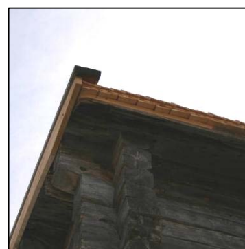
Del av nedre taktrobräda utbytt C-vägg. JLM CD 07101
