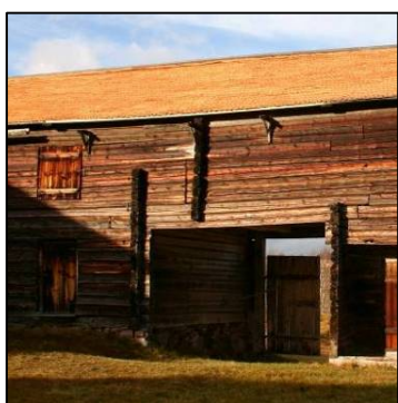
Del av nedre taktrobräda utbytt A-vägg. JLM CD 07101
