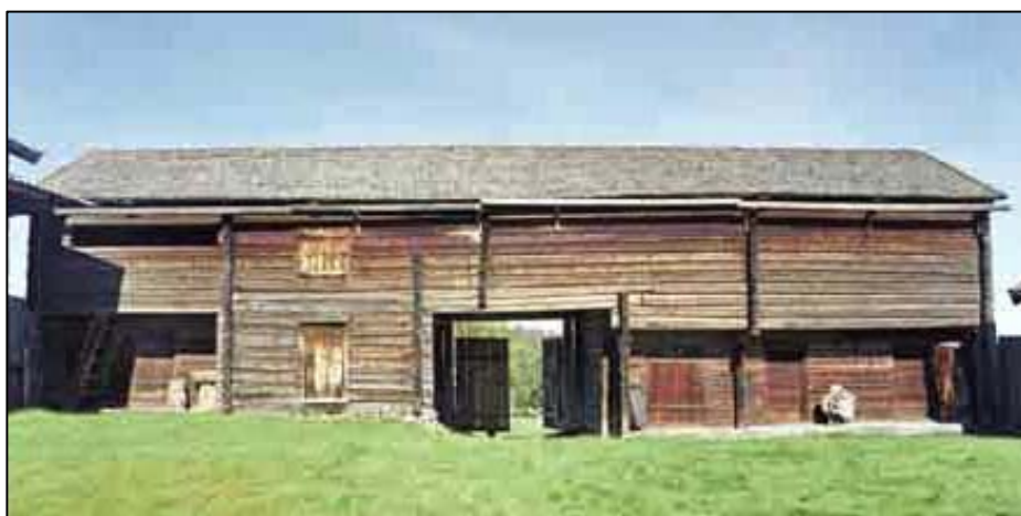
Byggnad VI. Stall/portlider/foderbodar före åtgärder.
