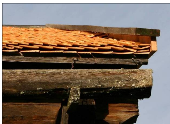
Detalj av spåntäckningen vid takfot. Spånen har lagts från vänster till höger i tre lager. JLM CD 07101
