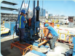
工友在鑽探機操作程序中加入「指差呼稱」指令，增加安全警覺性
