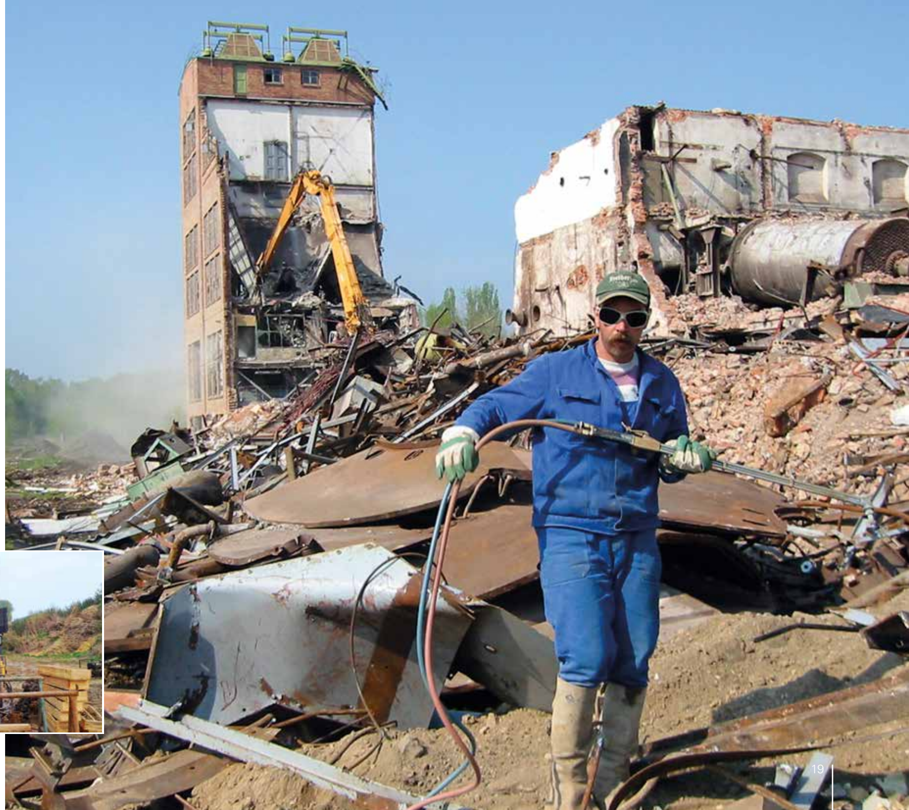
Abbruch mit schwerem Gerät an der Brikettfabrik Zechau, 2004
