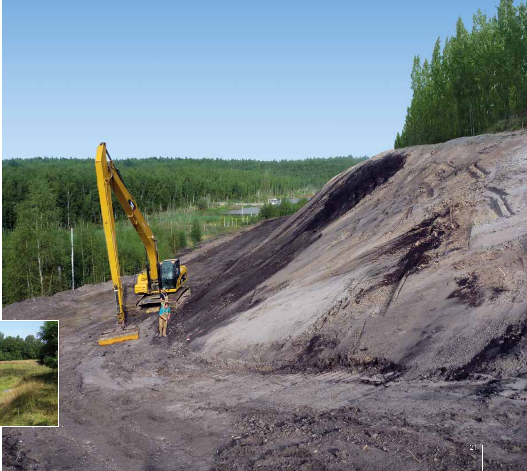
Vorbereitung zur Sicherung der Ost- böschung des Restloches Zechau III, 2010
