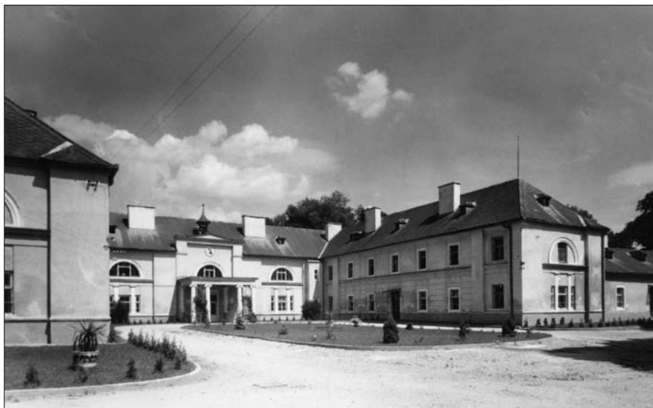
Forgáčovský kaštieľ v Ujlaku, postavený Jozefom Forgáčom v rokoch 1756 – 1761. Foto: Archív Pamiatkového úradu SR v Bratislave (stav z roku 1960).
