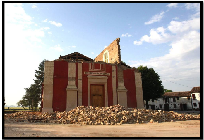
Chiesa di San Martino di Tours a Buonacompra, la mattina dopo il sisma del 20 maggio 2012.
