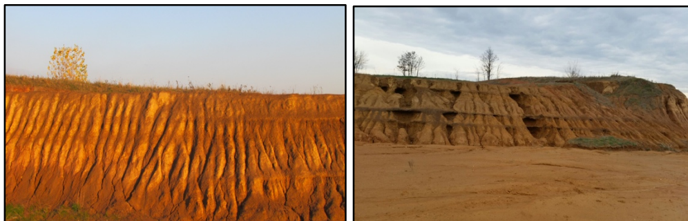
La sommità è caratterizzata da argille e loess che coprono completamente il colle; nelle zone dove la vegetazione è scarsa l'erosione continua la sua azione.
